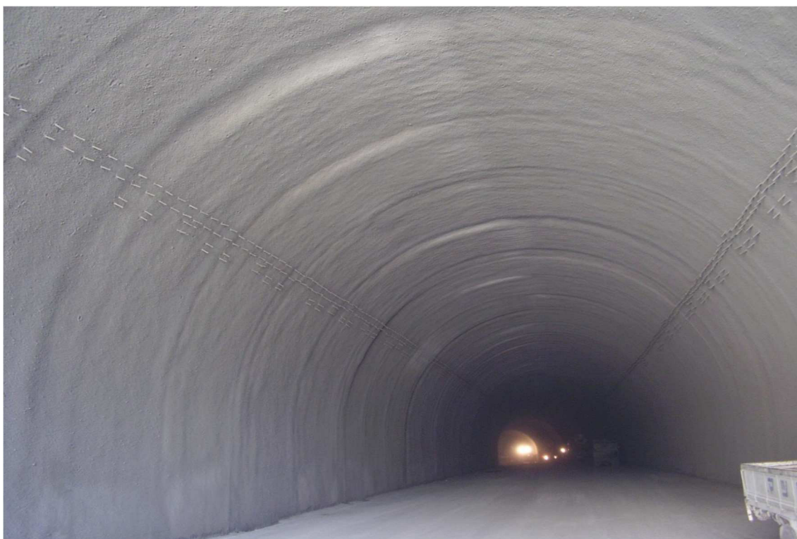
Obr. 2-9 Stříkaná izolace Masterseal 345 použita při rekonstrukci tunelu Chekka (Libanon) [45]
