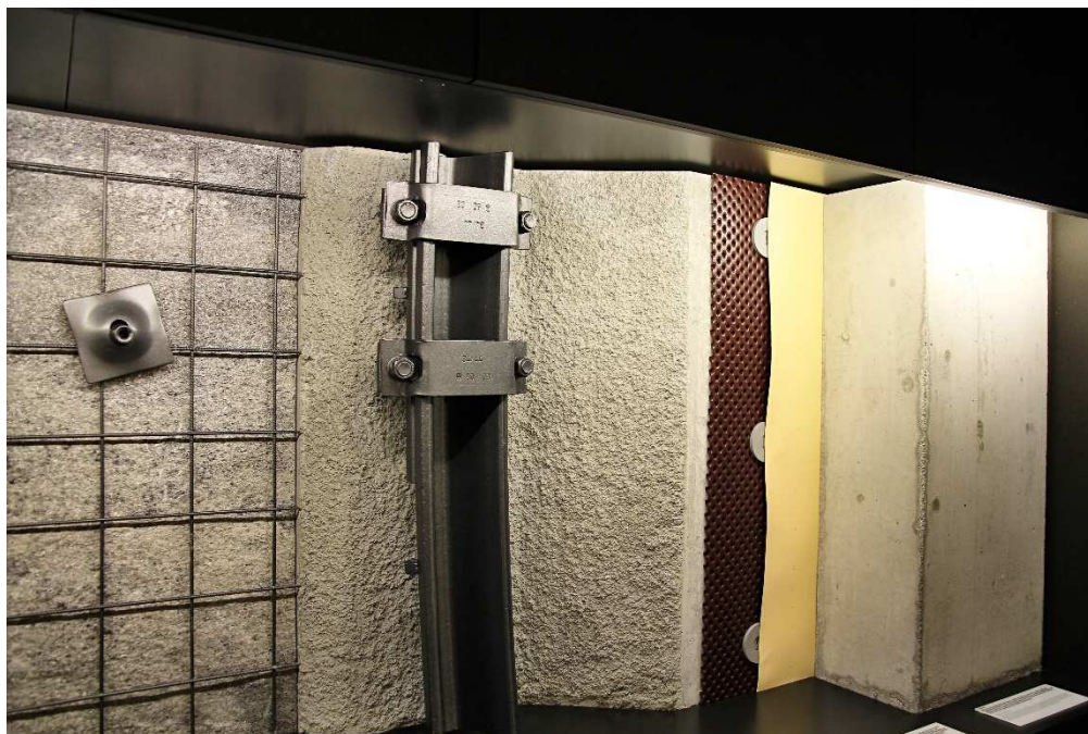
Obr. 2-8 Skladba obezdívky - Gotthardský bázový tunel [54]
