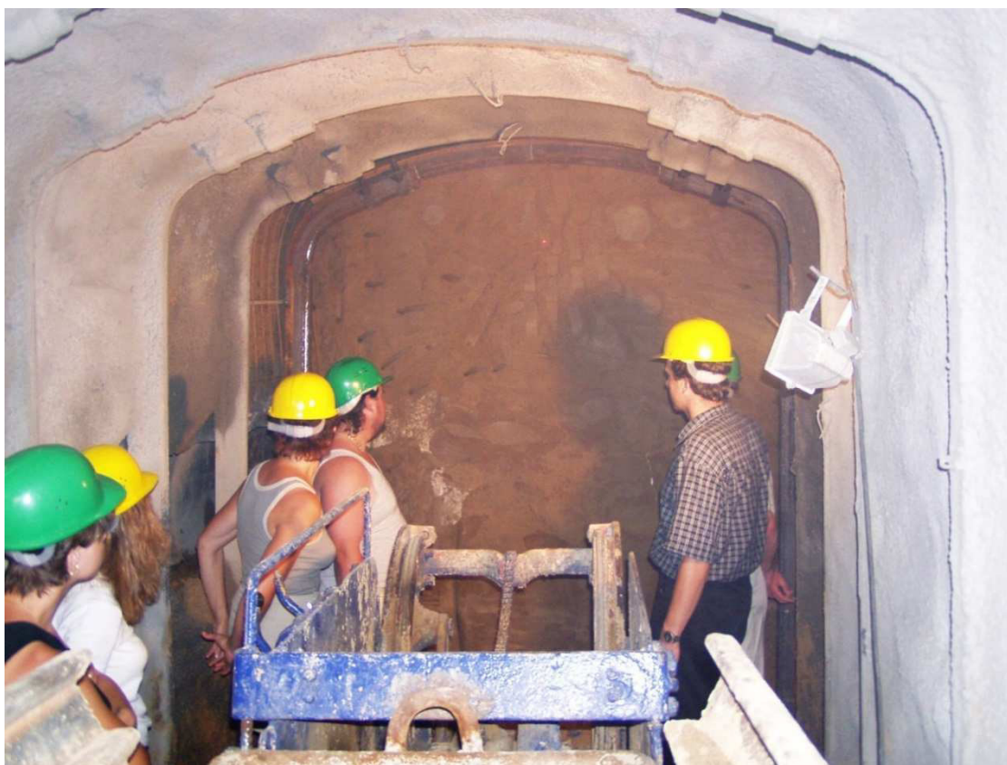
Obr. 5-2 Ilustrační fotografie situace na čelbě, stroj v popředí je klasický pneumatický nakladač [29]
