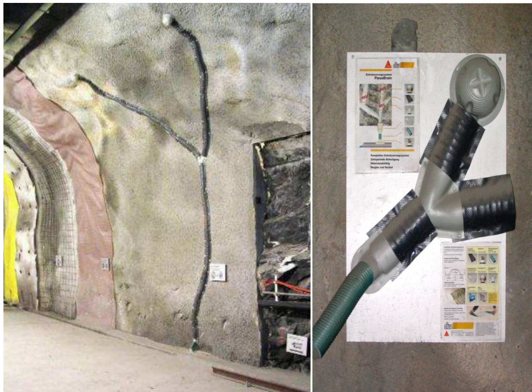
Obr. 2-14 Kombinace stříkané izolace a hadicové metody. Zkušební štoly Hagerbach (Švýcarsko) [28, 45]
