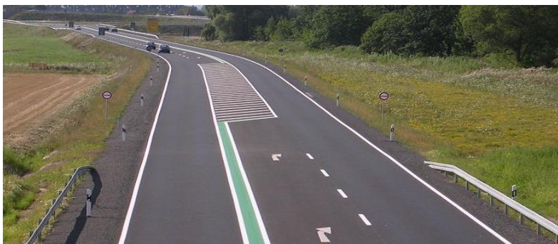
Obr.12 – Příklad použití bezpečnostní úpravy k oddělení dopravních směrů na 2+1 – Německo
