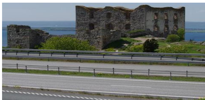
Obr.3 – Směrově dělená komunikace 2+1 pomocí lanového svodidla – Švédsko
