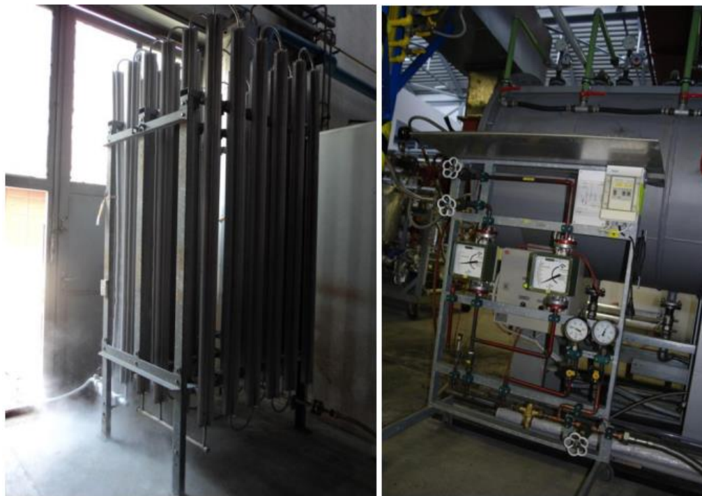
Obr. 17 – a) Výparník, b) měřicí panel.
