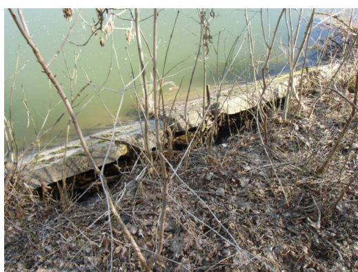
Opevnění břehů jezera panely
