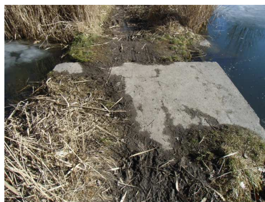
Hráz jezer Plavecké a Strakovo - propustek
