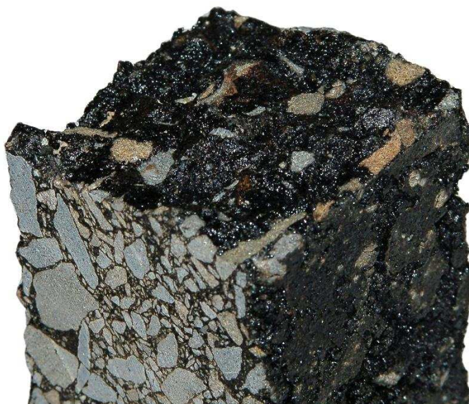
Obrázek 30: Porušení zkušebního tělesa mrazovou trhlinou
