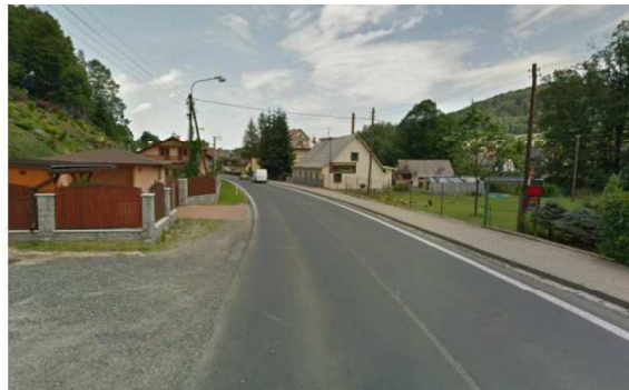
Obr.4: Komunikace I/44 – ZÚ
