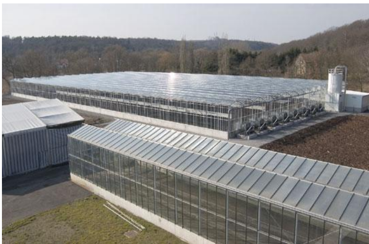
Obrázek 21: Skleníky solární sušárny kalu [2]
