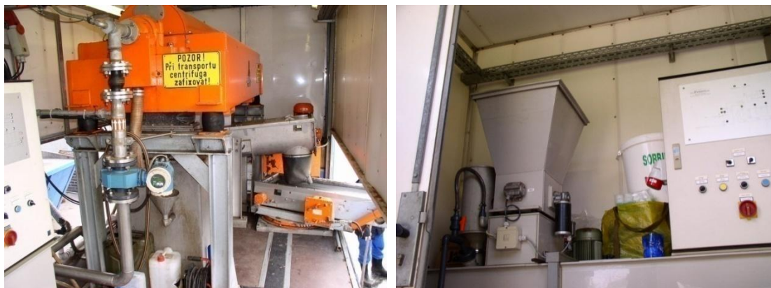
Obr. 20 Pohled na mobilní odstředivku (vlevo) a tříkomorový systém na míchání roztoku flokulantu
