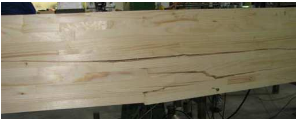
Obr. 31 – Porušení nosníku L01. [13]
