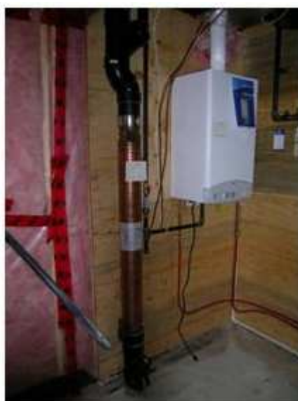
Obr. 17 Realizace výměníku v RD [17]
