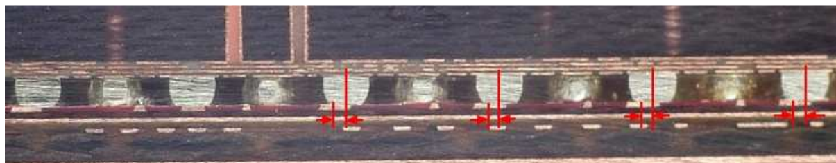
Obr. 67: Posunutí nebo pootočení pouzdra způsobilo špatné sesouhlasení pájecích plošek na desce plošných spojů (GPU ATI)
