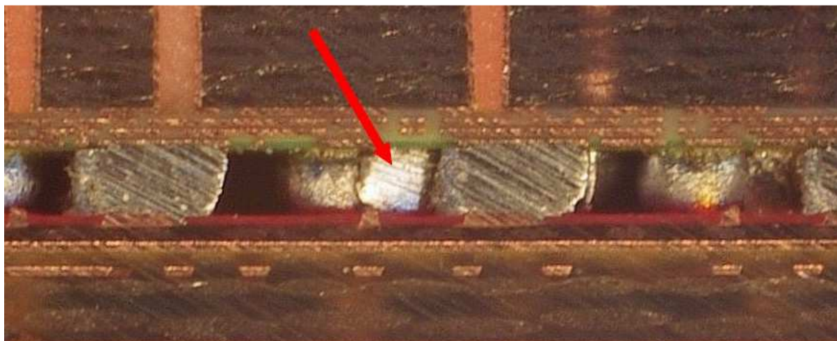
Obr. 60: Pájková kulička v prostoru mezi správně zapájenými vývody vytvářející zkrat (GPU ATI)
