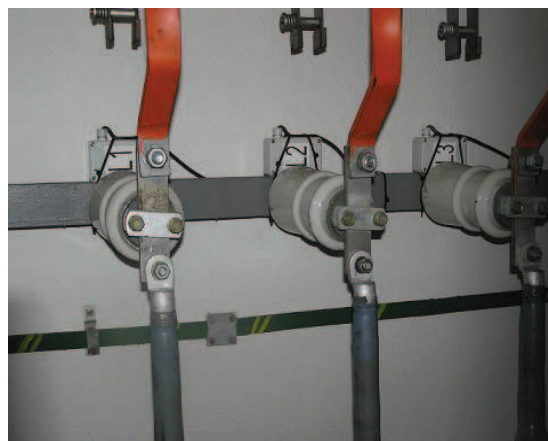
Obr. 91. Atypické umístění snímačů elektromagnetických polí
