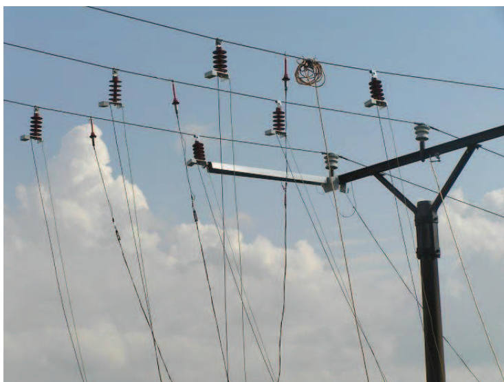
Obr. 85. Umístění snímačů, napěťových sond a vodiče pro ZS.
