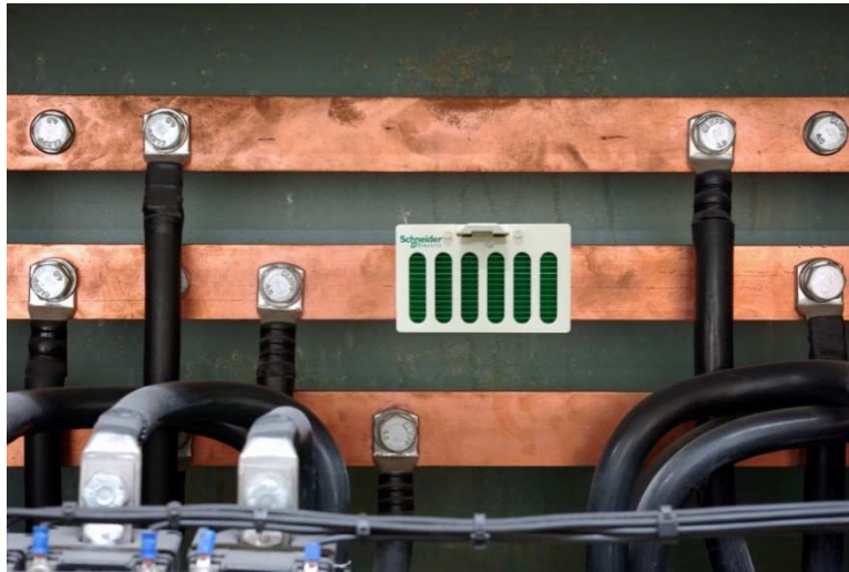
Obr. 14 Bezdrátový monitorovací systém sledující teplotu rozvodných vodičů [41]
