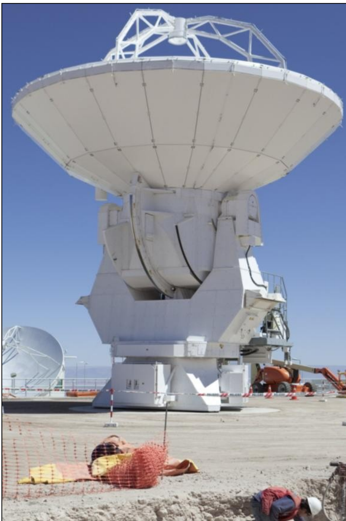
Obr. 3 Parabolická vysokofrekvenční anténa o průměru 15 metrů. 1
