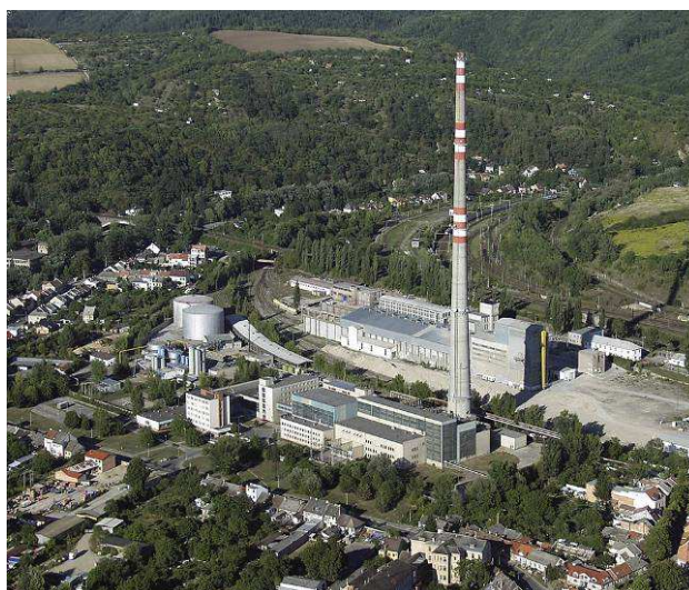
Obrázek 15: Letecký snímek provozu Brno-sever [27]
