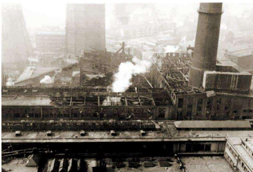
Obrázek 14: Požárem poškozené objekty tepláren - 1975, provoz Brno Špitálka [25]
