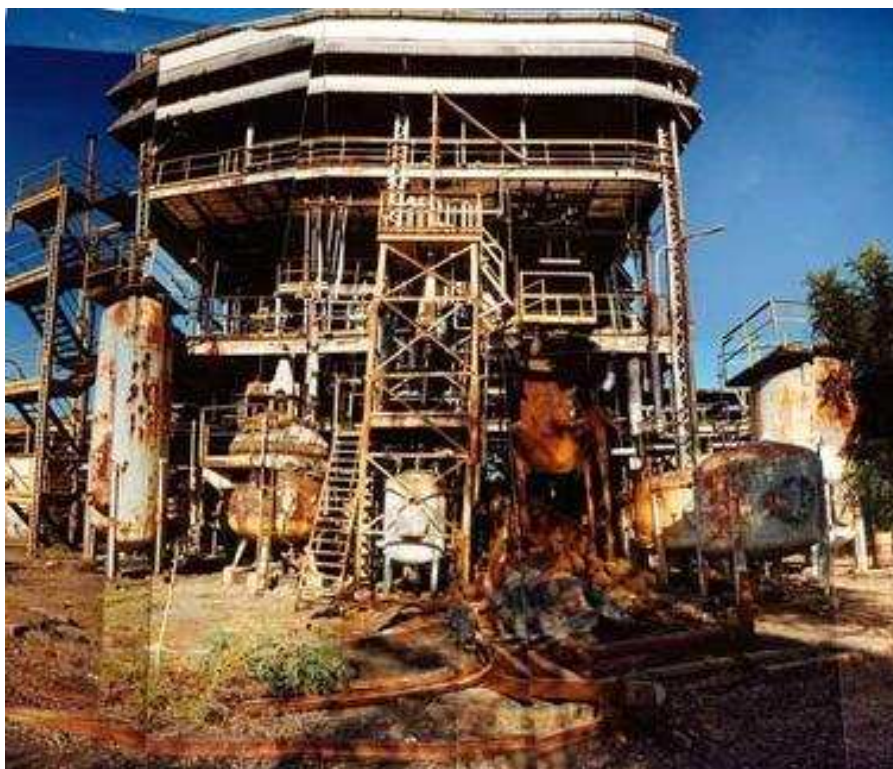
Obrázek 3: Pohled na opuštěnou továrnu chemičky Union Carbide - Bhopál (photo: Maude Dorr)
