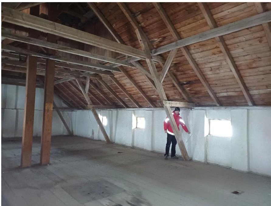
Obrázek 9 - Pohled na plnou vazbu krovu
