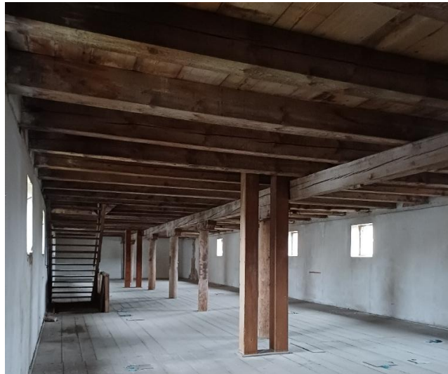
Obrázek 8 - Pohled do interiéru 2.NP
