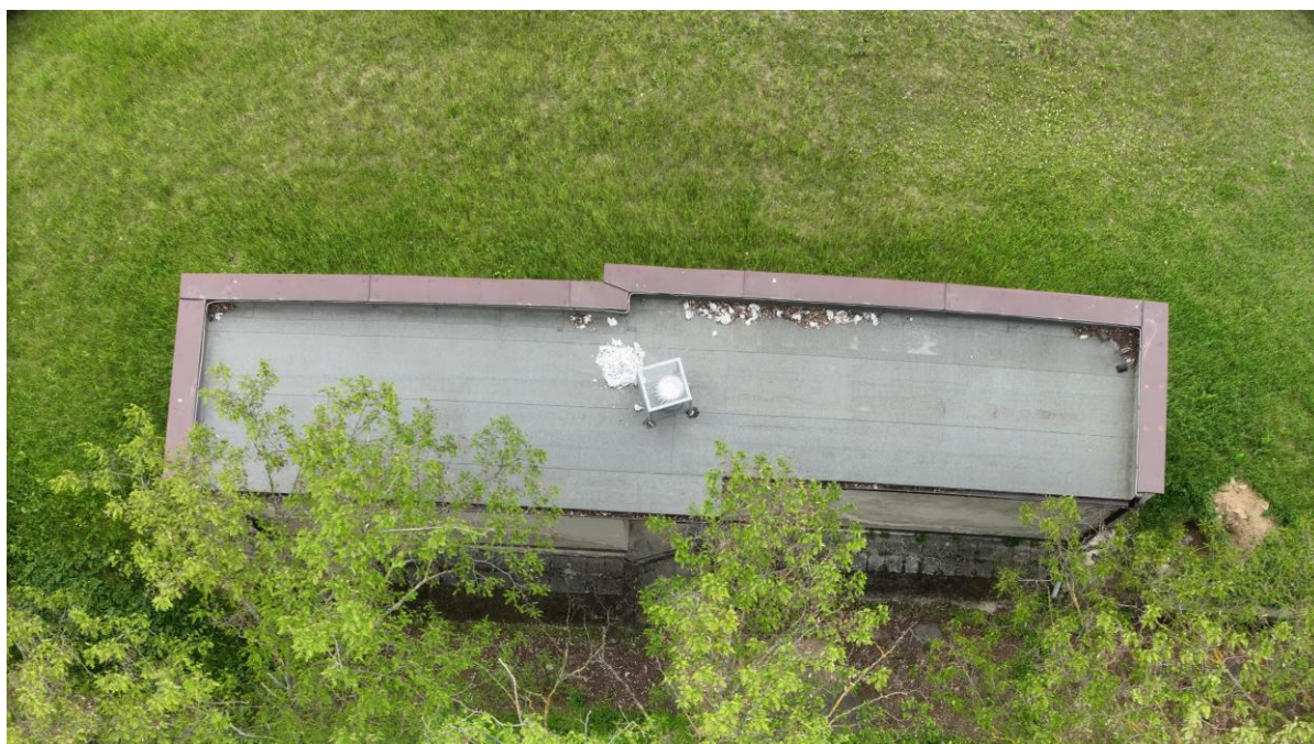
Obrázek 68 Snímek z dronu zachycuje pohled na střechu akumulční komory
