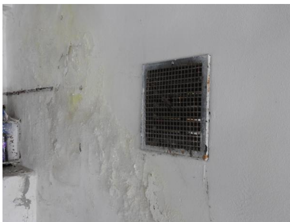
Obrázek 54 vlevo prostor mazací lávky, vpravo vzduchotechnika a degradace stěny
