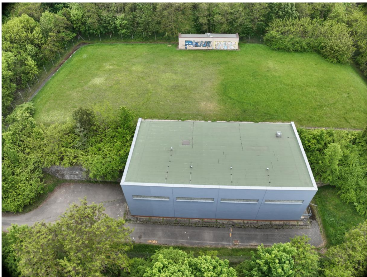
Obrázek 70 Snímek z dronu zachycuje pohled na areál vodojemu, kde se nachází armaturní komora vpředu, akumulční komora vzadu, nosné stěny a křoviny vedle armaturní komory a náletové křoviny a stromy nad pravou AN
