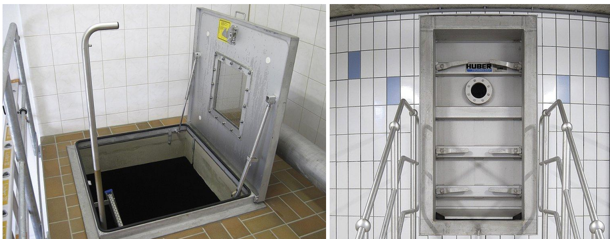
Obrázek 4 Těsnící poklop pro sestup do akumulční nádrže a vpravo vstupní dveře [8]
