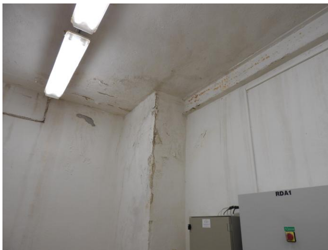
Obrázek 53 Vlevo detailní snímek rozvodní skříně, vpravo degradace stěny a stropu
