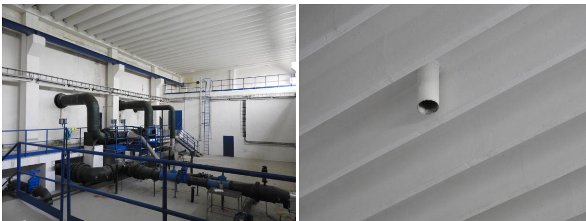
Obrázek 35 Vlevo pohled na armaturní komoru, vpravo odvětrání armaturní komory
