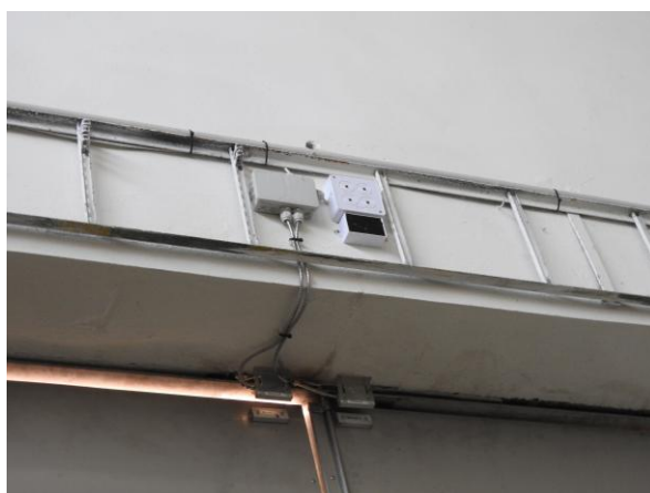
Obrázek 34 Alarmní čidlo při otevření dveří
