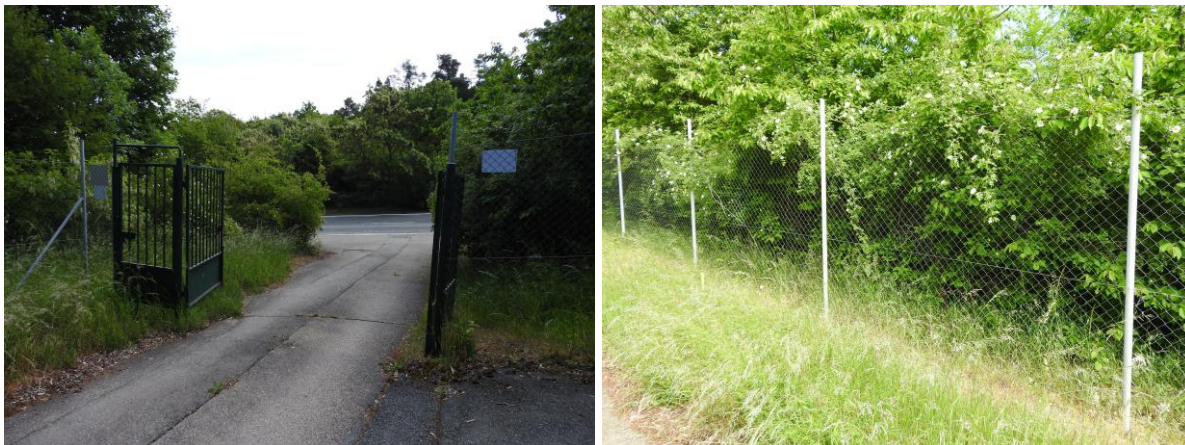
Obrázek 69 Vlevo příjezdová a vstupní branka do areálu, vpravo oplocení areálu
