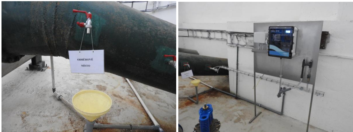
Obrázek 46 Vlevo odběrné místo vzorku z odběrného potrubí, vpravo analyzátor kvality vody
