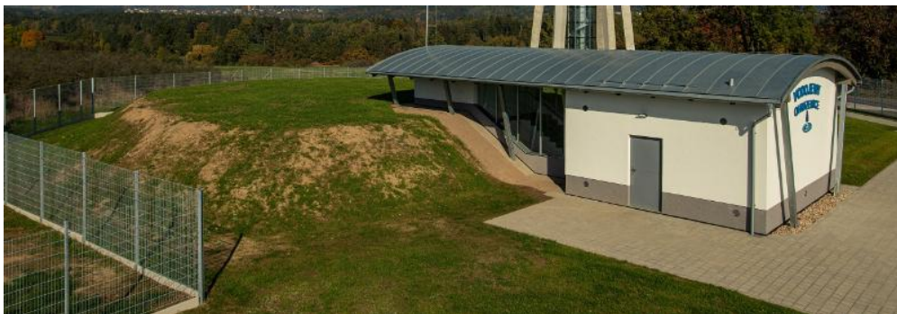
Obrázek 26 Zemní vodojem Ohrazenice [6]
