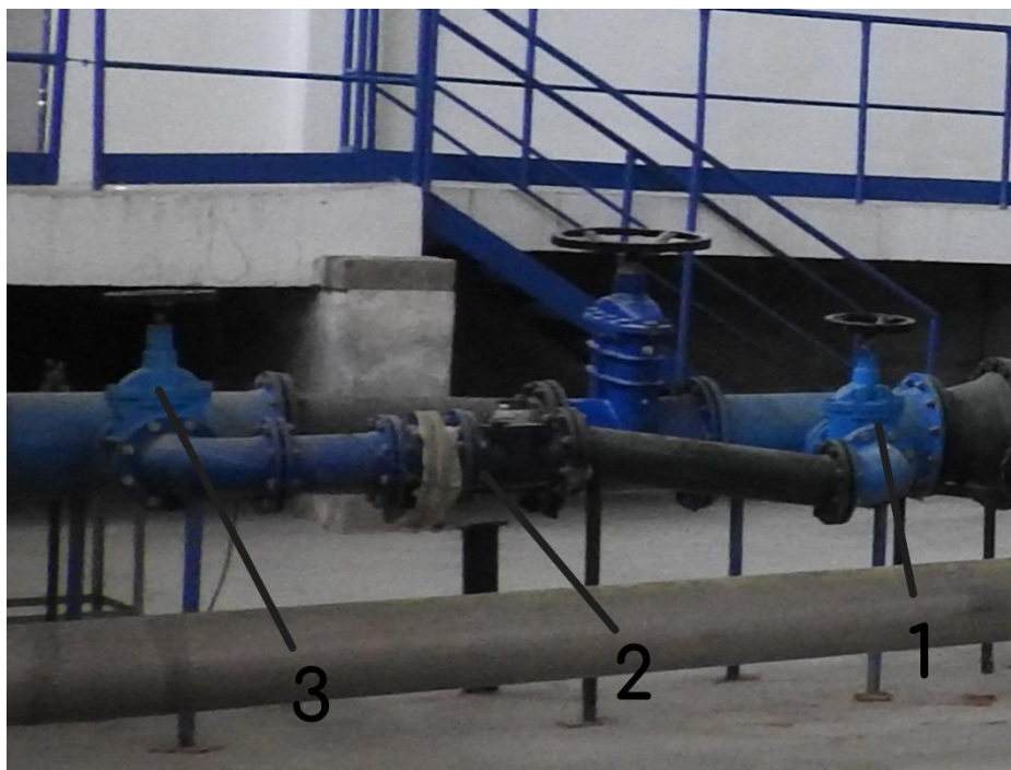
Obrázek 44 Obtokové potrubí
