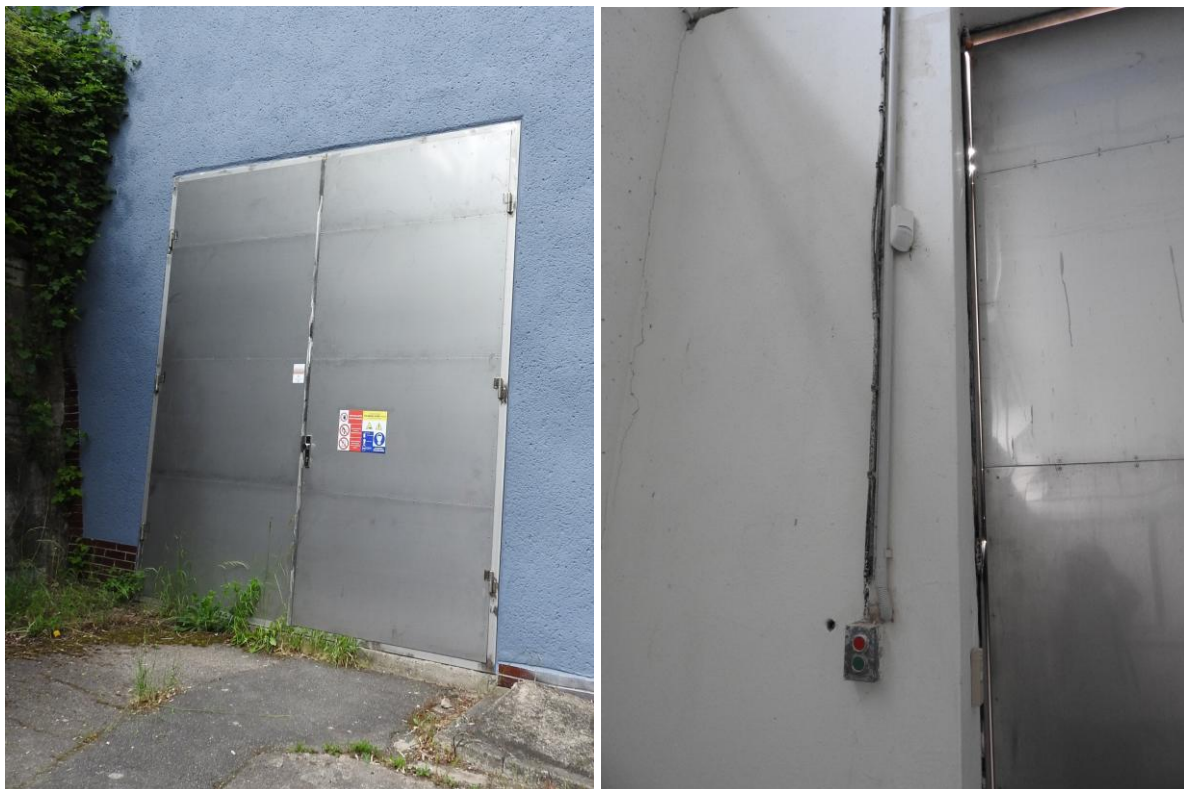
Obrázek 33 Vlevo dvoukřídlové ocelové vstupní dveře do objektu, vpravo senzor pohybu a ovládání světel
