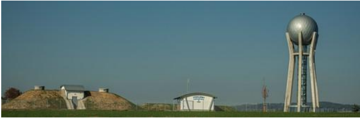
Obrázek 1 Areál vodojemů Ohrazenice, kde se nachází zemní vodojem vlevo s objemem 1000 \text{ m}^3 a armaturní komorou, věžový vodojem vpravo s objemem 150 \text{ m}^3 a armaturní komorou, která se nachází pod ním a uprostřed se nachází další zemní vodojem tentokrát o objemu 2 \times 300 \text{ m}^3 a armaturní komorou [6]
