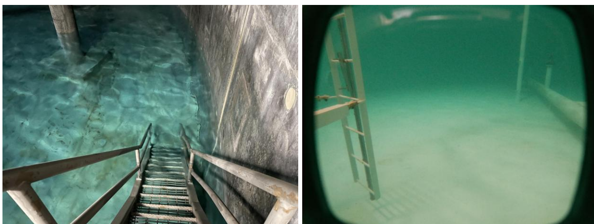
Obrázek 5 Vlevo schody pro sestup do vodojemu, vpravo žebřík pro sestup do vodojemu [9]
