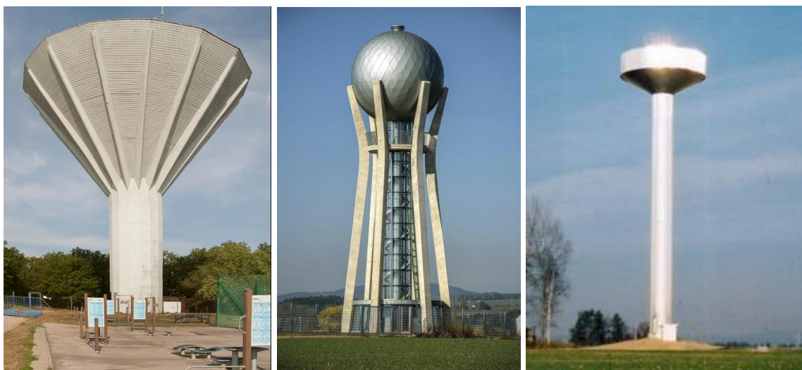
Obrázek 28 Vlevo kuželovitý vodojem Kohoutovice 700 m 3 , uprostřed kulovitý vodojem Ohrozenice 150 m 3 a vpravo čočkovitý vodojem [22] [6] [23]
