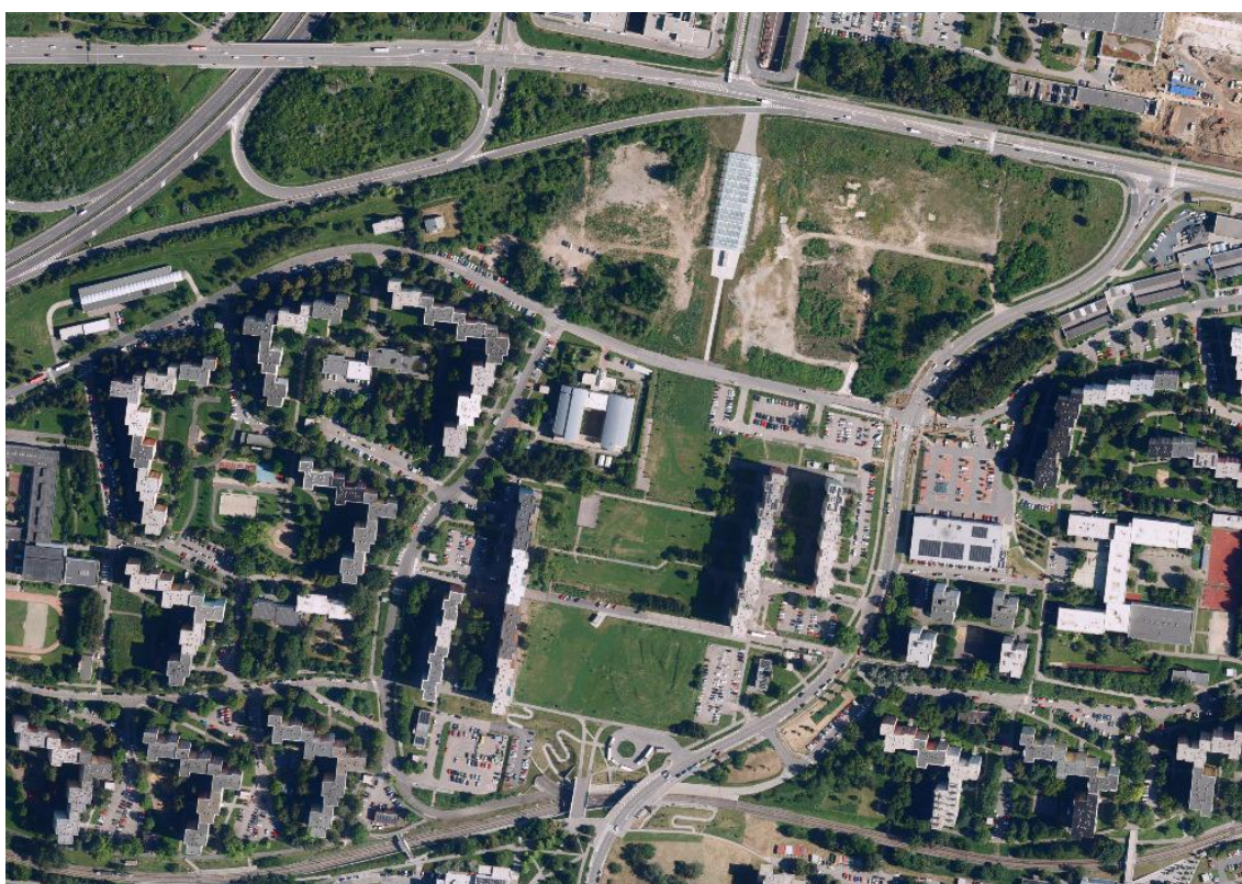
Obr. 33 letecký snímek stávajícího stavu Starého Lískovce [ https://mapy.cz/ ]
