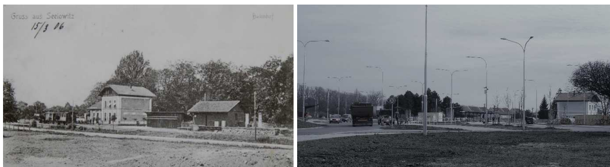
Obr.19. Původní podoba nádraží v Židlochovicích – 1899, 1906 a obnovení železničního spojení do Židlochovic spojená s adaptací dopravního přestupního uzlu – stav r.2018. (Zdroj: zidlochovice.cz, https://cs.m.wikipedia.org/wiki/Soubor:N%C3%A1dra%C5%BE%C3%AD_v_%C5%BDidlochovic%C3%ADch.JPG ). Foto: Barbora Jenčková.
