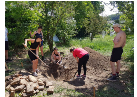
37 - projekt Pod ledovcem, tvorba formy pro skořepinu, FA VUT
