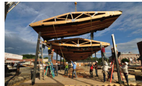
7 - design/buildLAB, design-build program na LabEx AE&CC, Ecole Nationale Supérieure v Grenoblu - prefabrikace a výstavba pavilonu farmářského trhu v Covingtonu ve Virginii. autor: design/buildLAB
