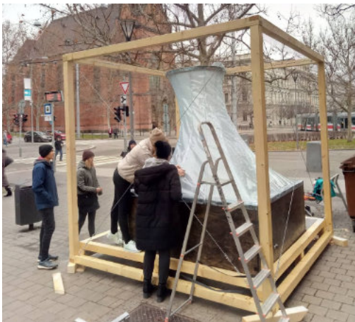
30 - projekt Městská oáza, zbytkové teplo z parovodu nad, kterým objekt stojí vytápí membránu a rostliny v ní, vedoucí projektu Martin Kaftan, FA VUT, 2020 Zdroj: Fakulta architektury VUT v Brně
