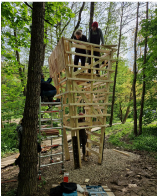
45 - projekt Dvě věže, konstrukce a práce na opláštění, Lelekovice a FA VUT, 2023 autor: Kristýna Smržová
