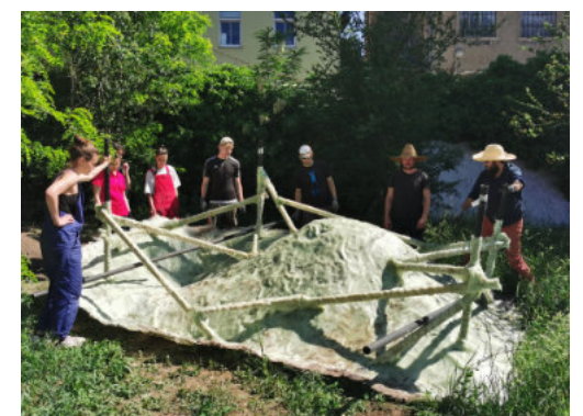
39 - projekt Pod ledovcem, tuhá skořepina se ztužujícími žebry, FA VUT
