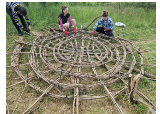
48 - projekt Koruna, vyplétání spodní části koše Koruny z větví místní náletové zeleně, v pozadí rám pro výplet koše Koruny, Lelekovice a FA VUT, 2023 autor: Kristýna Smržová
