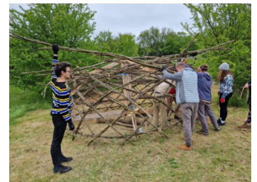
49 - projekt Koruna, vyplétání koše Koruny přes pomocný rám, v pozadí rám pro výplet koše Koruny, Lelekovice a FA VUT, 2023 autor: Kristýna Smržová
