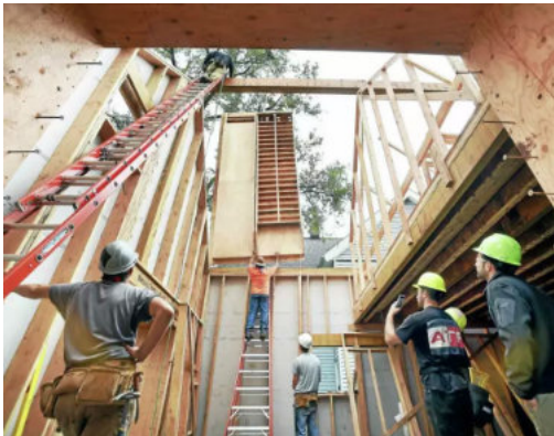
1 - Studenti Yale School of Architecture sledují, jak je střešní panel držený jeřábem umísťován na stavbu projektu Jim Vlock Building Project pro Columbus House na Adeline Street v New Havenu dne 8. srpna 2017. foto: Arnold Gold / Hearst Connecticut Media.
