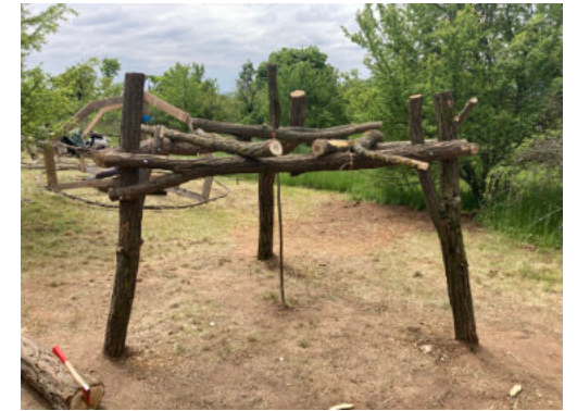
47 - projekt Koruna, základová konstrukce z akátových kmenů, v pozadí rám pro výplet koše Koruny, Lelekovice a FA VUT, 2023 autor: Lucie Nováčková
