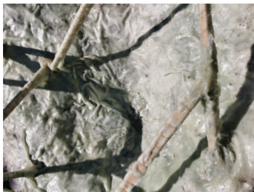
76 - projekt Pod ledovcem, povrch skořepiny, FA VUT autor: Igor Kuvac
