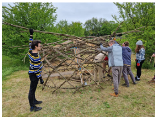
85 - projekt Koruna, vyplétání koše Koruny přes pomocný rám, v pozadí rám pro výplet koše Koruny, Lelekovice a FA VUT, 2023 autor: Kristýna Smržová
