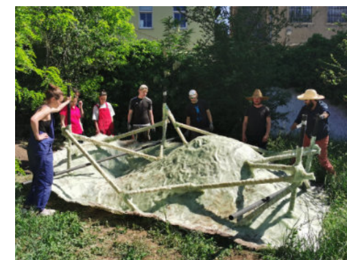
75 - projekt Pod ledovcem, tuhá skořepina se ztužujícími žebry, FA VUT autor: Kristýna Smržová
