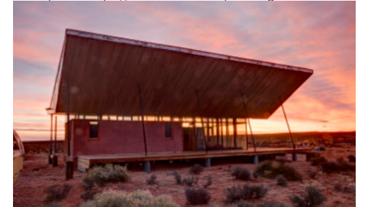
29 - Colorado Building Workshop + DesignBuildBLUFF, Studenti se využili stávající základ a prvky typizované budovy, která na pozemku stála při návrhu svého řešení.2013 autor: Jesse Kuroiwa
