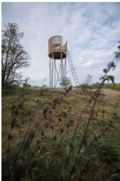
56 - 1:1 lab FA ČVUT, design-build projekt 3 posedy, ateliér Hlaváček - Čeněk, Libčice nad Vltavou, 2021 autoři: Martin Čeněk, Jiří Ryszawy, Lubomír Kotek, 1:1lab, FA ČVUT
