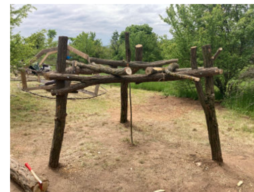
83 - projekt Koruna, základová konstrukce z akátových kmenů, v pozadí rám pro výplet koše Koruny, Lelekovice a FA VUT, 2023 autor: Lucie Nováčková
