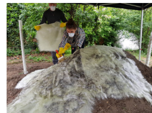
74 - projekt Pod ledovcem, pokládání sklolaminátových kusů, FA VUT autor: Kristýna Smržová
