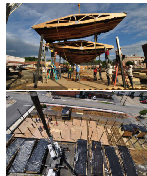
13 a 14 - design/buildLAB, design-build program na LabEx AE&CC, Ecole Nationale Supérieure v Grenoblu - prefabrikace a výstavba pavilonu farmářského trhu v Covingtonu ve Virginii. autor: design/buildLAB
