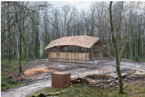
27 a 28 - Studenti z AA v Londýně postavili roboticky vyrobenou stodolu v lese v Dorsetu v Anglii, přičemž použili dřevo získané z okolních stromů, 2016 zdroj: AA Design & Make, Dezeen
