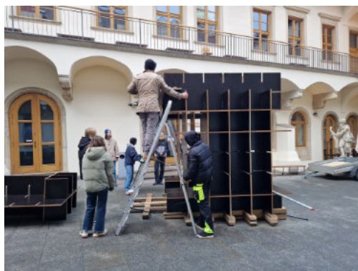
92 - projekt Skládačka, Betlém/ koledomat, práce na místě, sestavování objektu, FA VUT, 2023 autor: Kristýna Smržová
