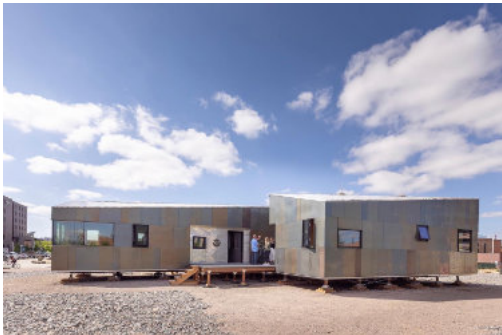
52 - projekt Holt Watters Field Camp Phase I, ColoradoBuildingWorkshop, antarktická stanice, vedoucí Erick Sommerfeld, 2022 zdroj: ColoradoBuildingWorkshop
