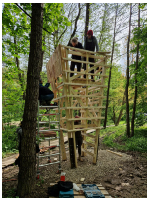
81 - projekt Dvě věže, konstrukce a práce na opláštění, Lelekovice a FA VUT, 2023 autor: Kristýna Smržová
