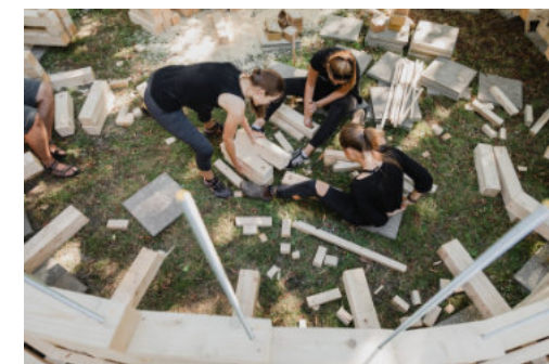
12 - Koloseum, design-build workshop FA VUT, realizace na místě, MČ Brno - sever autor: Viola Hertelová
