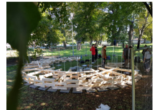
62 - projekt Koloseum, počáteční práce na konstrukci objektu, FA VUT autor: Kristýna Smržová
