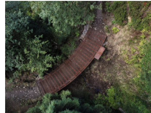
54 - 1:1 lab FA ČVUT, design-build projekt Lávka přes Hlubokou struhu 2019, ateliér Hlaváček - Čeněk, KRNP autoři: Martin Čeněk, Jan Kyncl, Tomáš Minarovič, Eliška Müllerová, Jiří Ryszawy, 1:1lab, FA ČVUT
