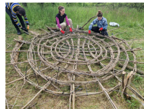
84 - projekt Koruna, vyplétání spodní části koše Koruny z větví místní náletové zeleně, v pozadí rám pro výplet koše Koruny, Lelekovice a FA VUT, 2023 autor: Kristýna Smržová
