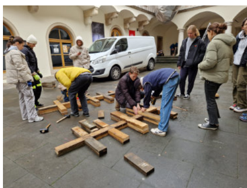
91 - projekt Skládačka, Betlém/ koledomat, práce na místě, zhotovení vyrovnávacího soklu, FA VUT, 2023 autor: Kristýna Smržová
