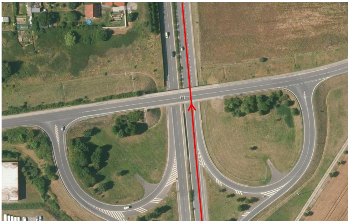
Obrázek č. 41: Podjezd č. 27-077B.2 silnice I/27 [11]
