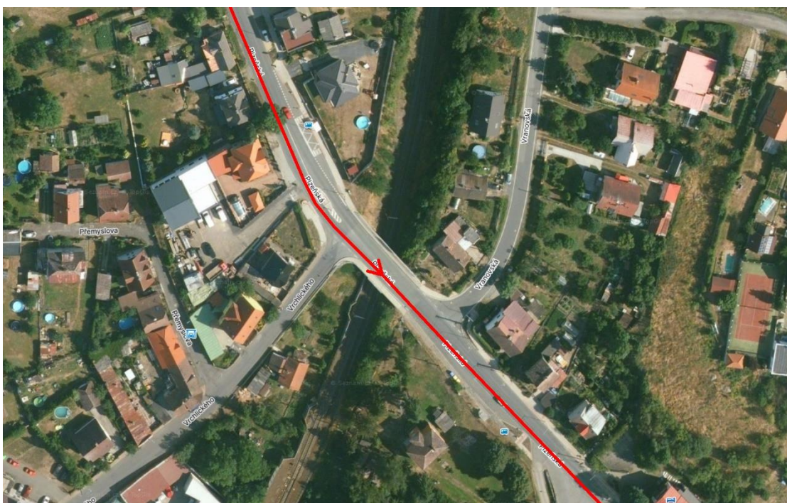
Obrázek č. 21: Most č. 605-065 silnice II/605 [20]
