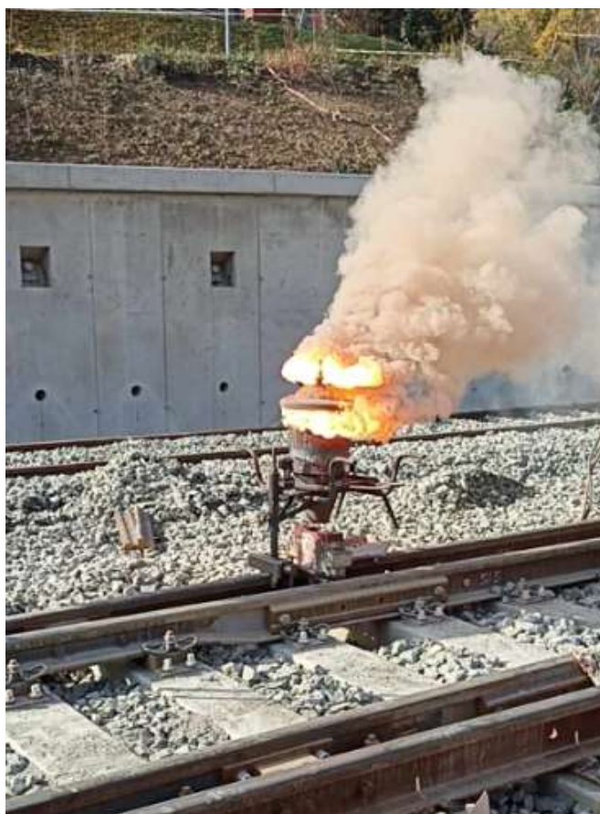
Obr. 17 - Aluminotermické svařování; Zdroj: vlastní
