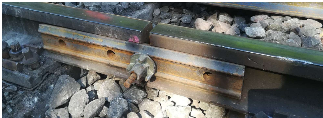
Obr. 26 - zajištění polohy čel kolejnic; Zdroj: vlastní
