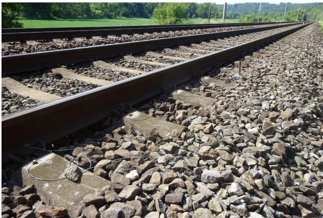
Obrázek 29 - Osazení snímačů zrychlení, zdroj: autor
