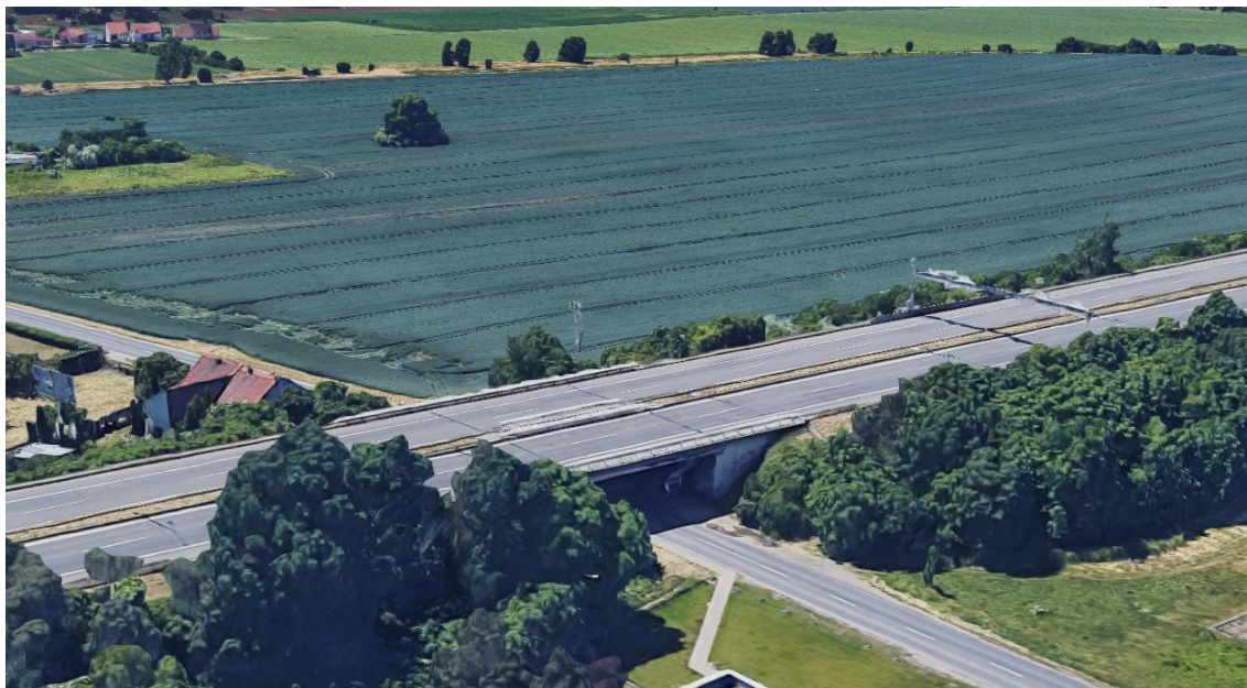
Obrázek 13 - podjezd ul. Kšírova pod dálnicí D1, pohled směr Modřice
