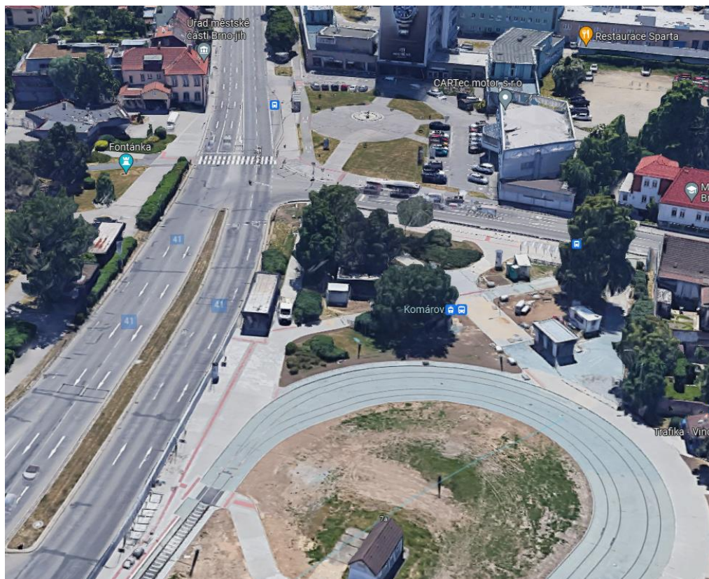
Obrázek 11 - smyčka Komárov, pohled směr dálnice D1
