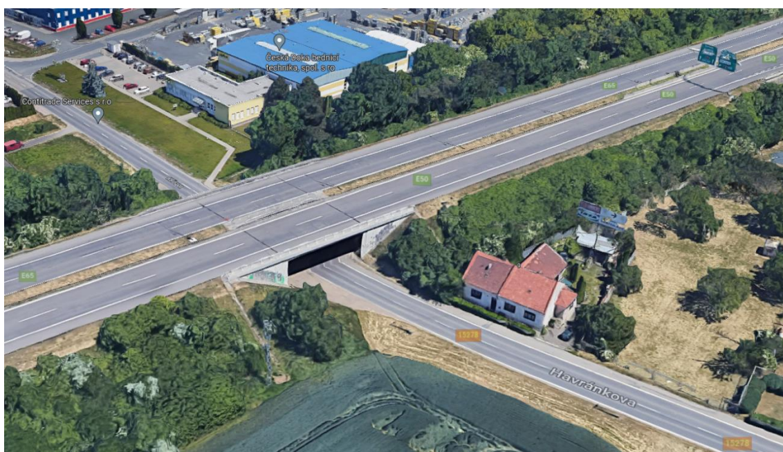
Obrázek 12 - podjezd ul. Kšířova pod dálnicí D1, pohled směr Komárov
