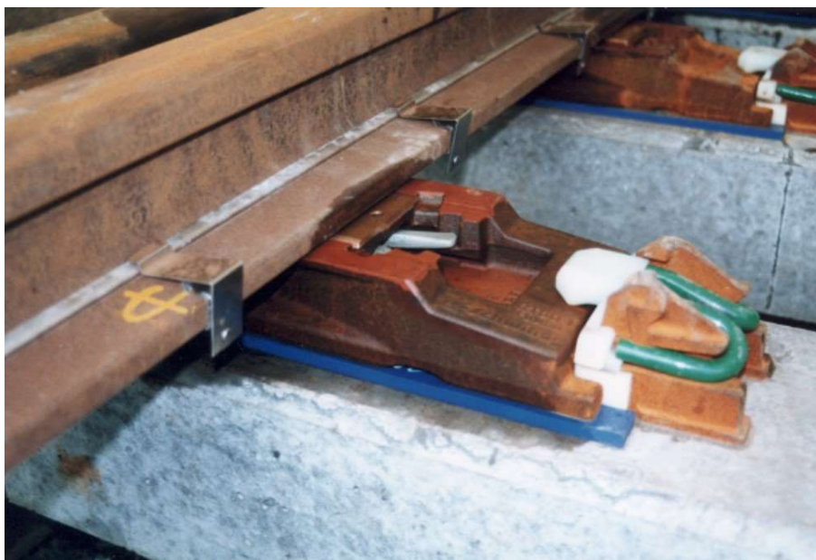
Obr. 45 Systém Pandrol DFC použitý jako kluzná stolička ve výhybce. [79]
