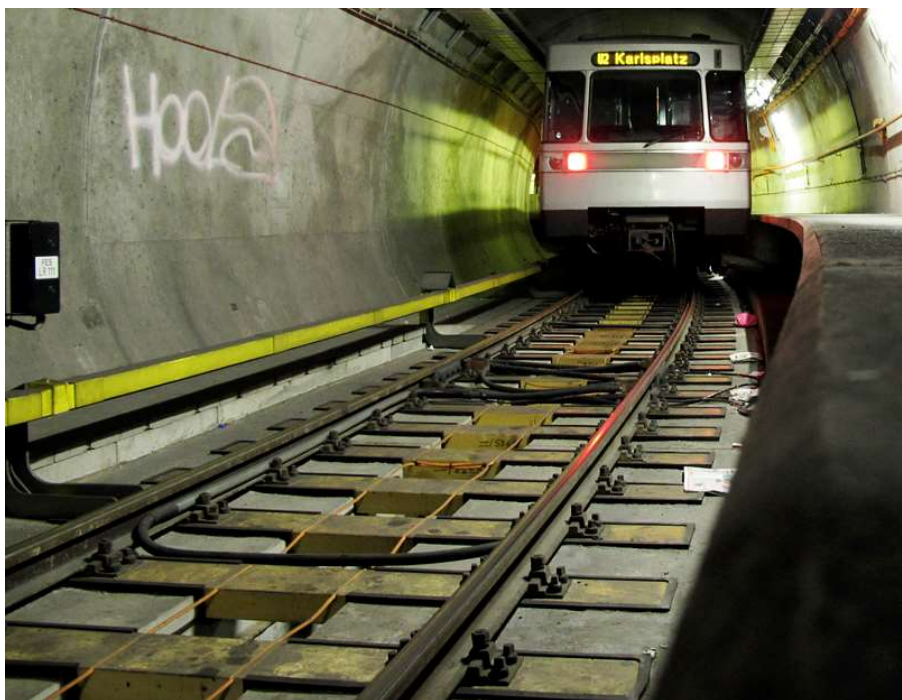
Obr. 50 Konstrukce PJD ve vídeňském metru vč. patrného obvyklého upevnění „K“ a zpružnění pražců v uložení. 10
