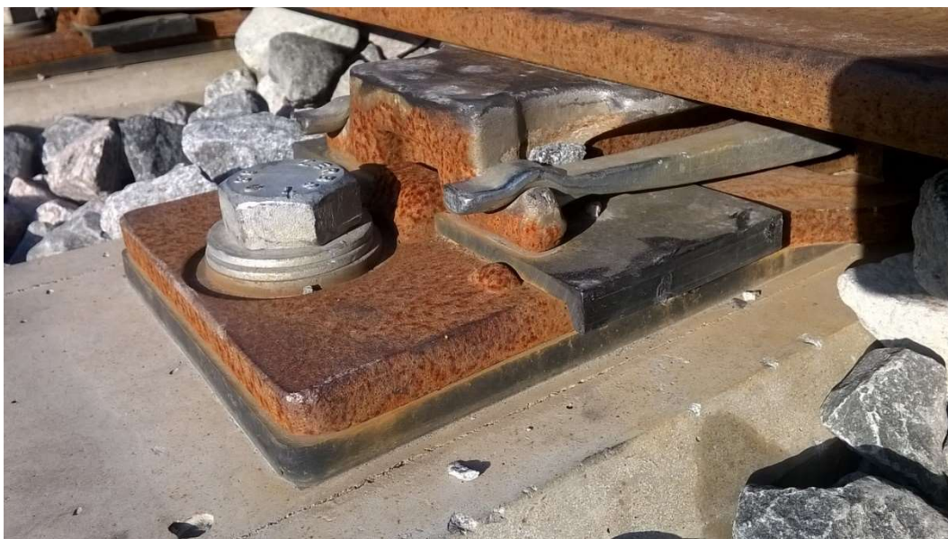
Obr. 51 Kluzná stolička firmy Schwing se zpružněnou kluznou plochou a se zpružněním ještě i pod podkladnicí.
