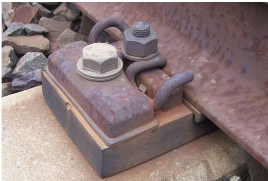
Obr. 30 Zpružněný systém upevnění ERL na výhybce BVG v žst. Poříčany.
