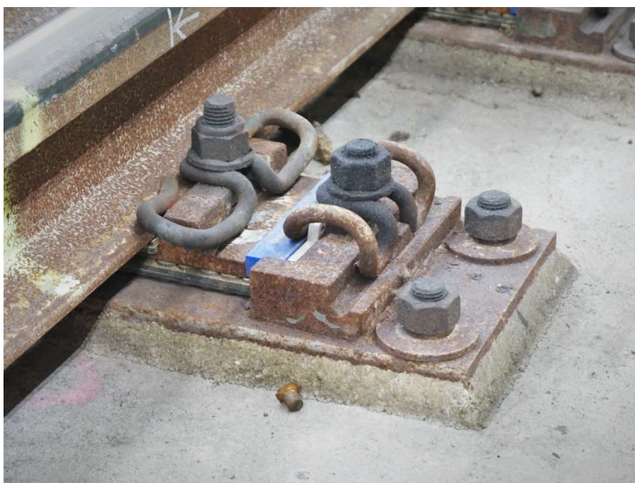
Obr. 38 Dvoupatrový zpružněný systém upevnění používaný v pražském metru. Pod žebrovou podkladnicí je patrná profilovaná pryžová pružná podložka, modrý plastový prvek pod ramínky vnější svěrky Skl Aekp má izolační funkci a pod touto svěrkou je ještě patrná bílá plastová vymezovací vložka sloužící pro úpravu příčné polohy kolejnice.
