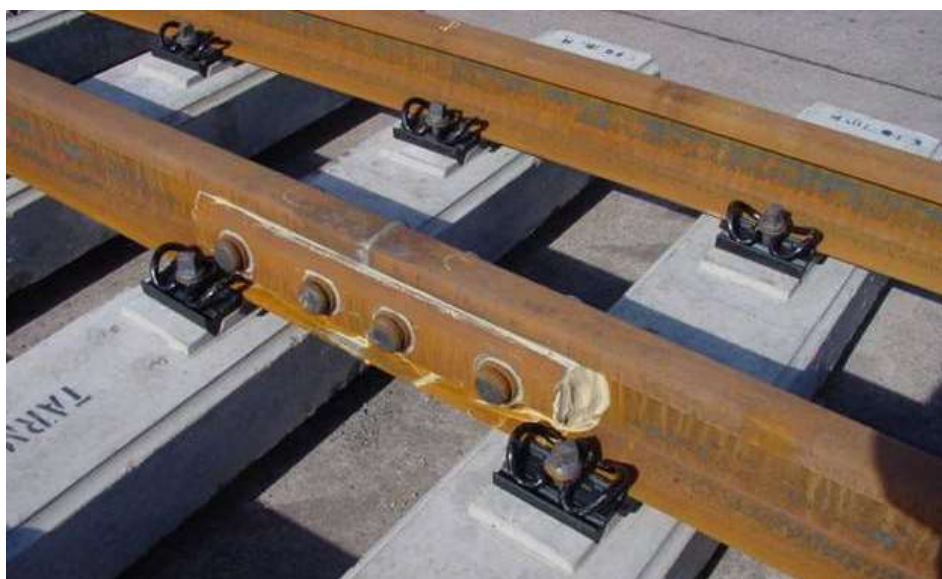
Obr. 42 Upevnění W 21 T ve výhybce. [57]
