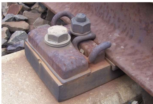
Obr. 5 Zpružněný systém upevnění ERL na výhybce BWG v žst. Poříčany.
