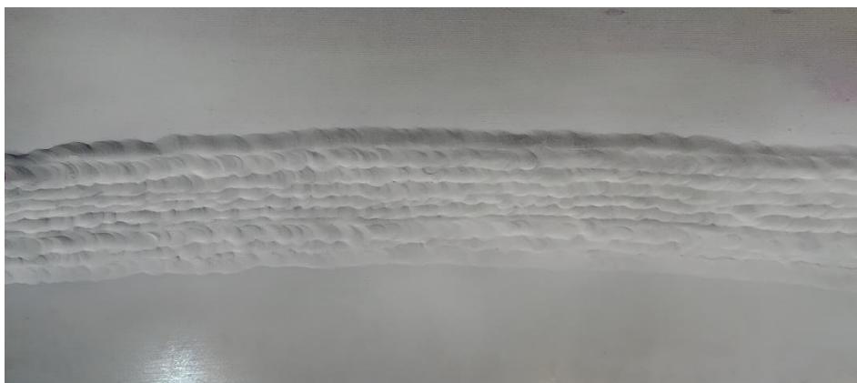
Obr. 56 Kontrola PT krycích vrstev.
