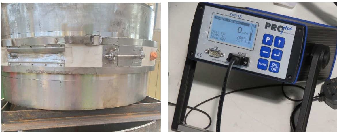
Obr. 51 Ochrana kořenové vrstvy argonem a měření zbytkového kyslíku.
