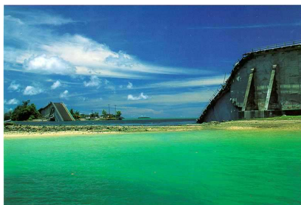
Obr. 2: Nadměrné deformace a následné zřícení mostu Koror-Babeldaob, převzato z [20]
