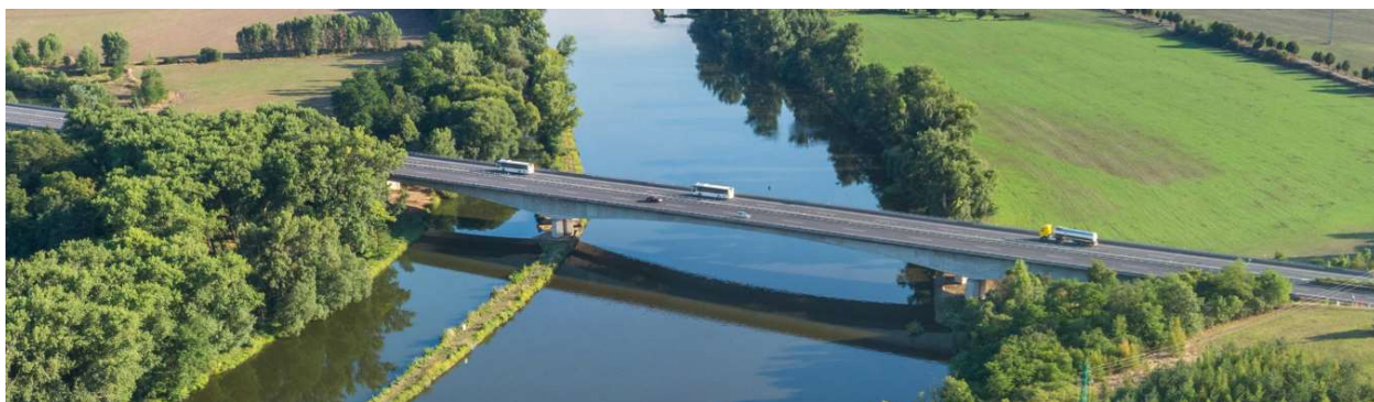
Obr. 1: Letmo betonovaná mostní konstrukce u obce Vepřek, převzato z [19]
