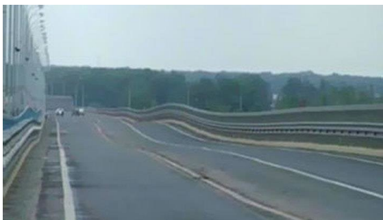
Obr. 2.11 Rozkmitaný most ve Volgogradu [32] Obr. 2.12 Rozkmitaný most [33]
