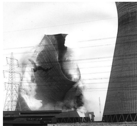
Obr. 2.10 Zřícení 3. chladicí věže [31]
