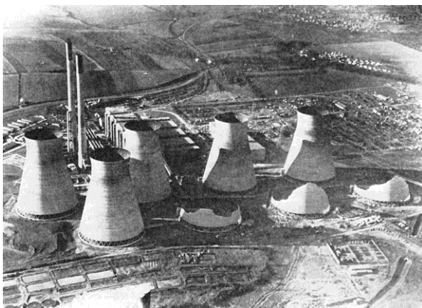
Obr. 2.9 Uspořádání chladicích věží elektrárny Ferrybridge, 3 věže jsou již zničeny [30]
