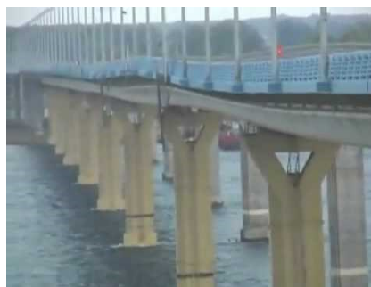
Obr. 2.11 Rozkmitaný most ve Volgogradu [32] Obr. 2.12 Rozkmitaný most [33]
