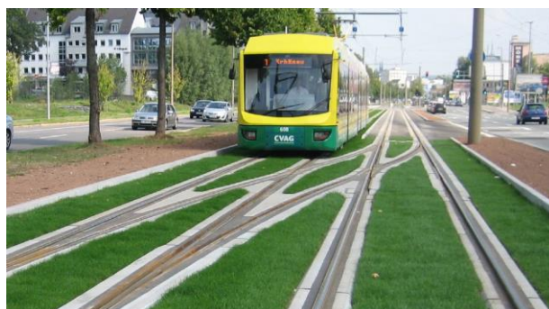
Obrázek 3.17 Zelená trať se systémem edilon)(sedra USTS v Saské Kamenici [39]
