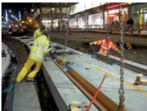
Obrázek 3.15 Pokládka betonových panelů edilon)(sedra USTS [38]
