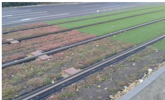
Obrázek 3.10 Rozhraní mezi povrchem z umělého trávníku a rozchodníků
