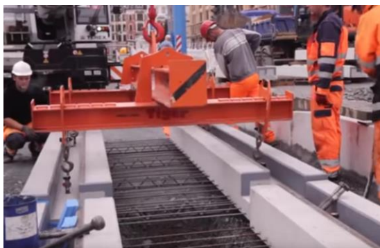
Obrázek 3.16 Osazování prefabrikovaných betonových žlabů [39]
