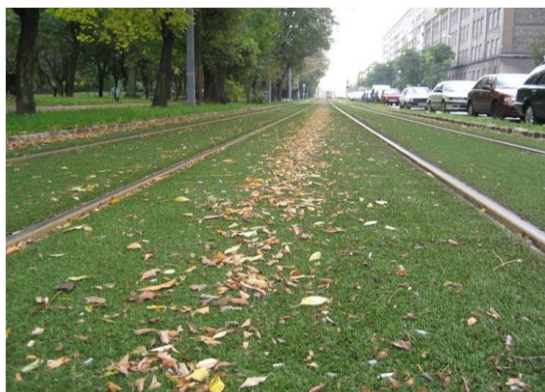
Obrázek 3.33 Zelená trať s krytem z umělého trávníku v Budapešti
