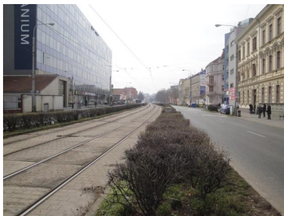
Obrázek 4.2 Pohled na stávající stav trati na ulici Nové Sady
