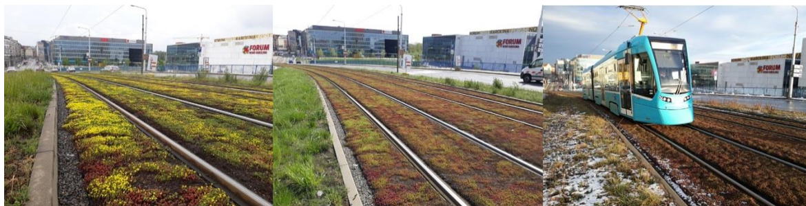
Obrázek 3.4 Povrch tratě s rozchodníky na jaře, v létě a v zimě (Ostrava) [30]
