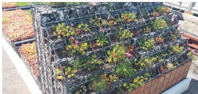
Obrázek 3.5 Protihluková clona BRENS BARRIER [31]
