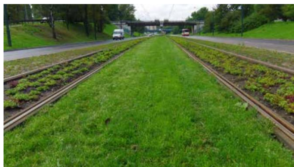
Obrázek 3.26 Povrch trati v polském Sosnowci s použitým systémem RHEDA CITY GREEN [6]
