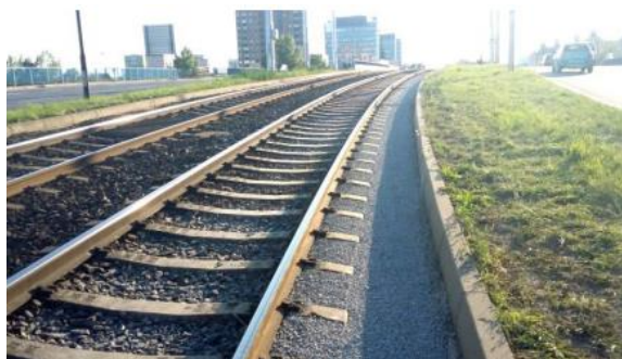
Obrázek 3.7 Původní stav zkušebního úseku [20]
