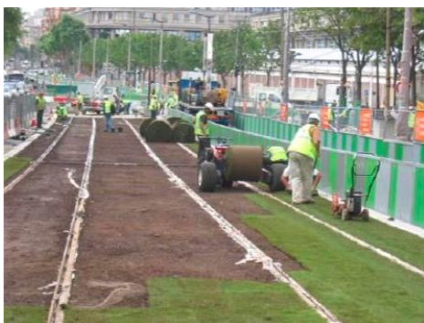
Obrázek 2.26 Pokládka trávniku při prodloužení tramvajové linky T3 v Paříži [27]
