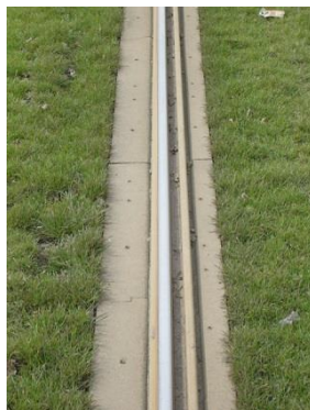
Obrázek 3.12 Kolejnice s bokovnicí SEDRAPUR
