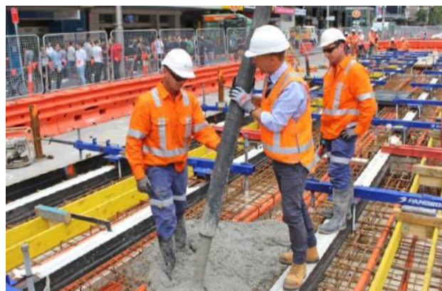
Obrázek 3.32 Betonování systému QT JIG [11]
