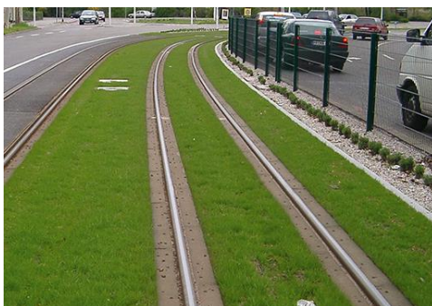
Obrázek 3.24 Systém INPLACE ve Frankfurtu nad Mohanem [43]
