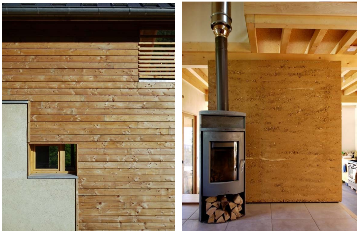
Obr. 59: Nízkoenergetický rodinný dům v horském prostředí. Detail řešení fasády a masivní akumulční stěny z dusadé hlíny. Exteriér a interiér rodinného domu v Corbel, Savoie, Francie, Eco-Caracol architect, dostupné z: http://www.eco-caracol.com/ecoconstruction.php#
