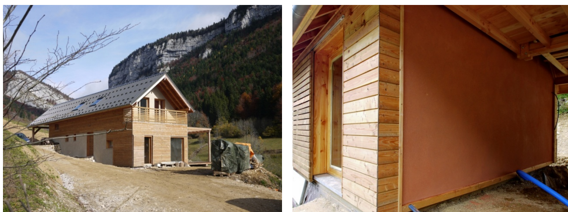
Obr. 60: Nízkoenergetická rodinný dům v horském prostředí. Exteriér a interiér Rodinného domu v Corbel, Savoie, Francie, Eco-Caracol architect, dostupné z: http://www.eco-caracol.com/ecoconstruction.php#
