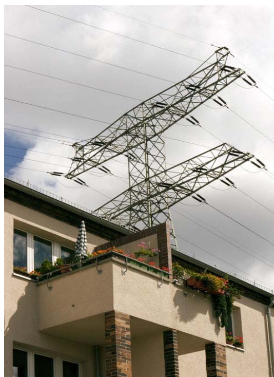
Obr. 5: Obytná budova pod dráty vysokého napětí nedodržující odstupové vzdálenost. Zdroj: http://www.infonetz-owl.de/index.php?id=100
