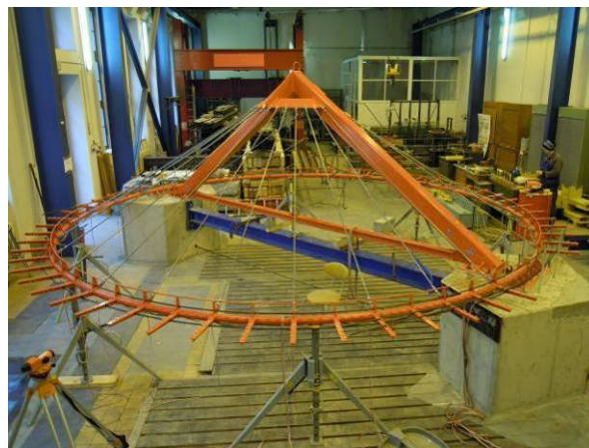
Obr. 7.7 Osazení závěsů, montážní podepření mostovky
