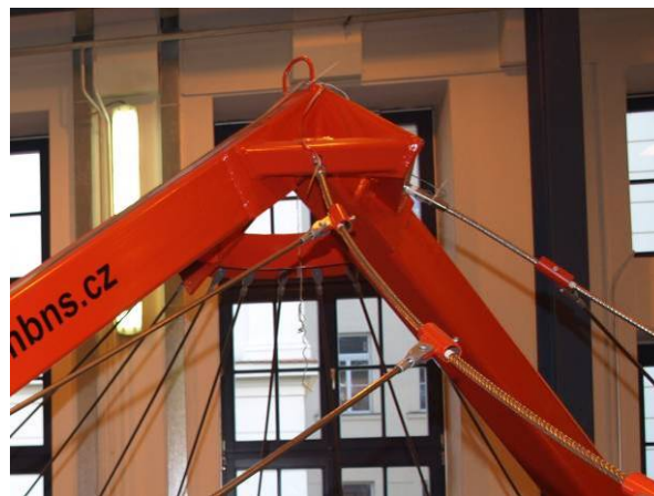
Obr. 7.15 Detail kotvení visutého lana
