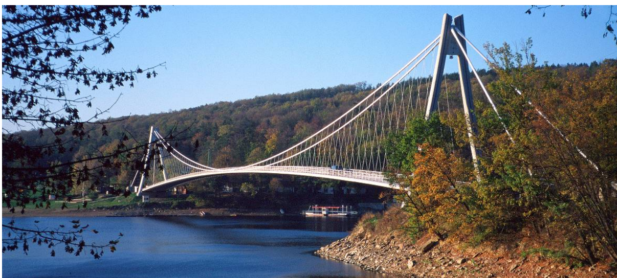
Obr. 1.3 Visutá lávka přes Švýcarskou zátoku na Vranovské přehradě
