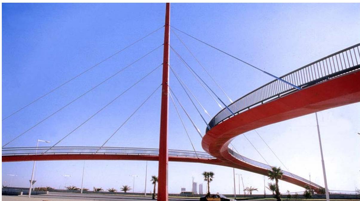
Obr. 1.7 Glorias Catalanans Bridge, Barcelona, Španělsko
