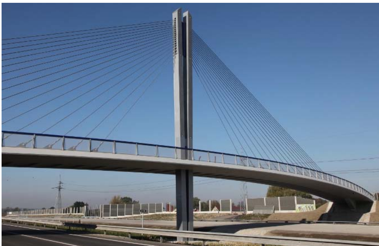
Obr. 1.9 Zavěšená lávka přes dálnici D47 u Bohumína, ČR
