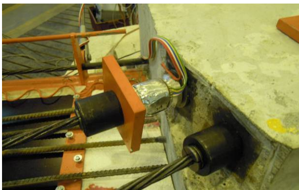
Obr. 7.21 Siloměr SV01 pod kotvou kabelu
