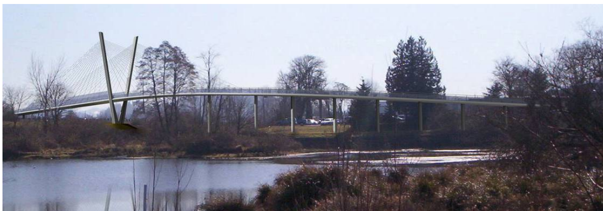
Obr. 1.4 Zavěšená lávka přes komunikaci Delta Pond, Eugene, Oregon, USA [36]
