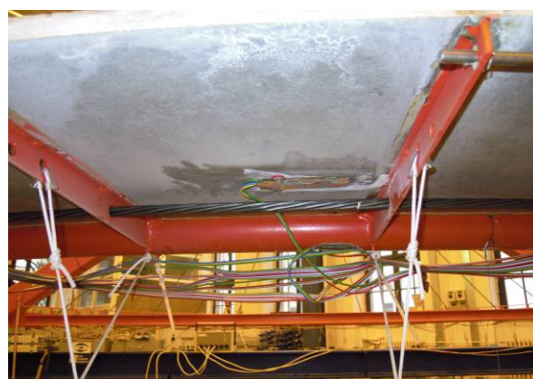
Obr. 7.19 Tenzometry na mostovkové desce
