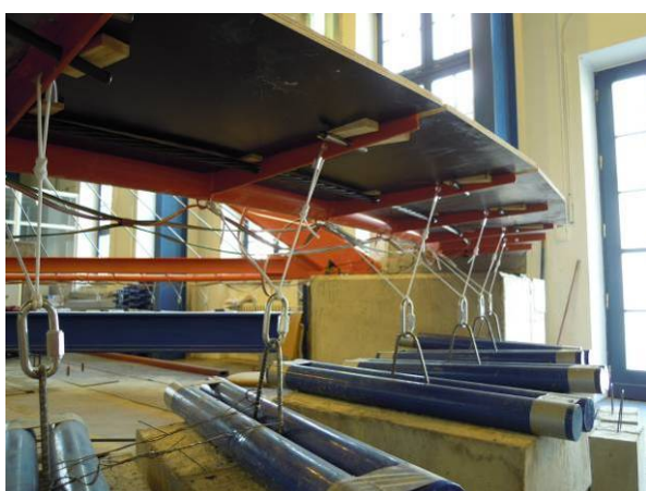
Obr. 7.10 Osazení závaží a bednění mostovky
