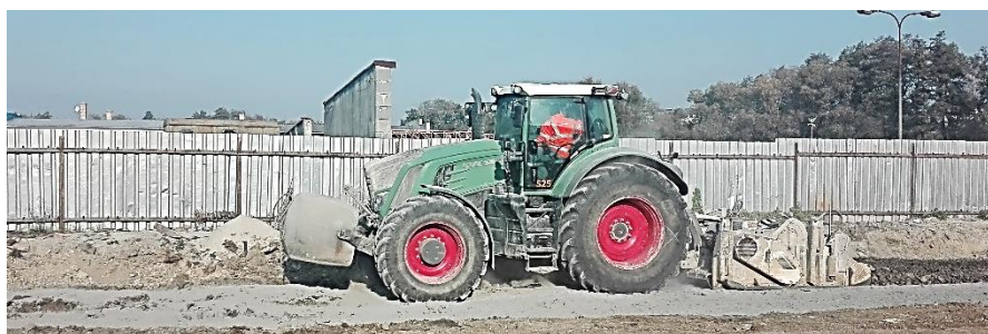
Obr. 16: Fréza připojená za traktorem
