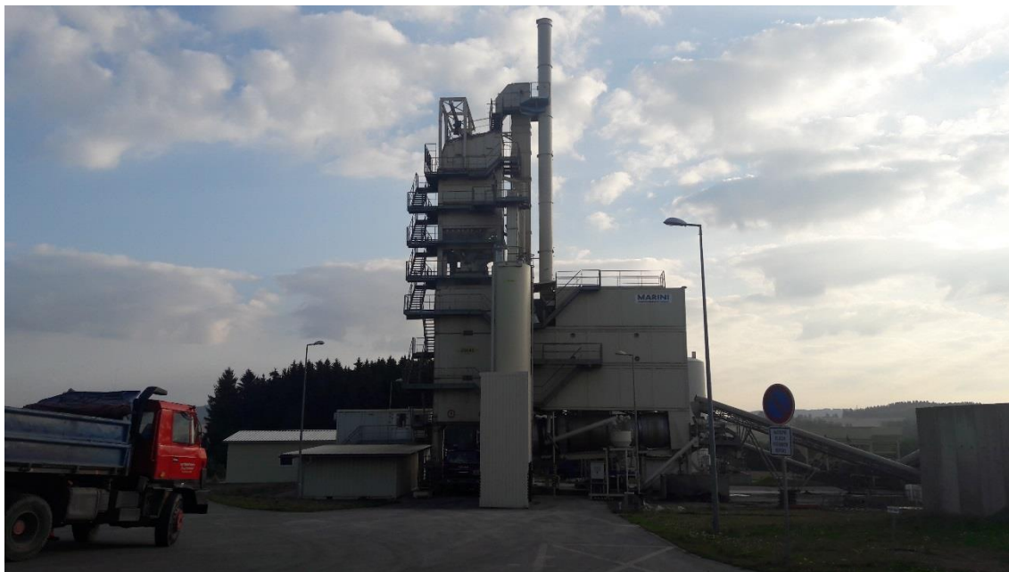
Obrázek 10: Šaržová obalovna v Bystřici nad Pernštejnem firmy COLAS CZ
