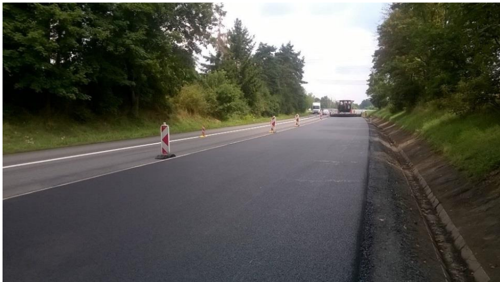
Obrázek 1: Pokládka ohrubné vrstvy netuhé vozovky [4]
