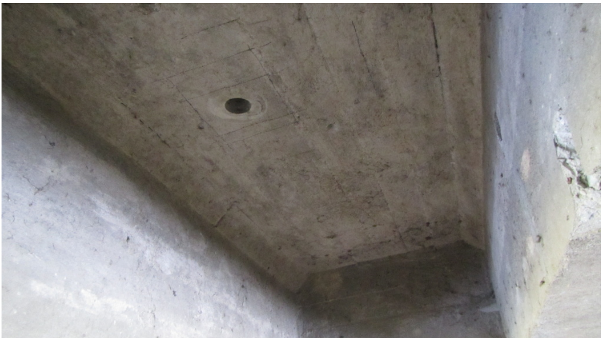
Obr. 62 Pohľad na miesto vykonanej sondy VD-1
