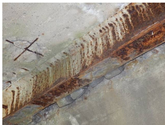
Obr. 45 Dôsledok rozpadnutej rímasy - kocky sa prepadajú [20]
