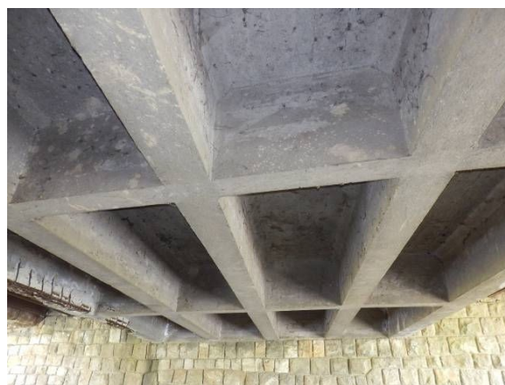
Obr. 35 Priesaky okolo starého odvodňovača a pohľad na vnútorné trámy a pole [20]
