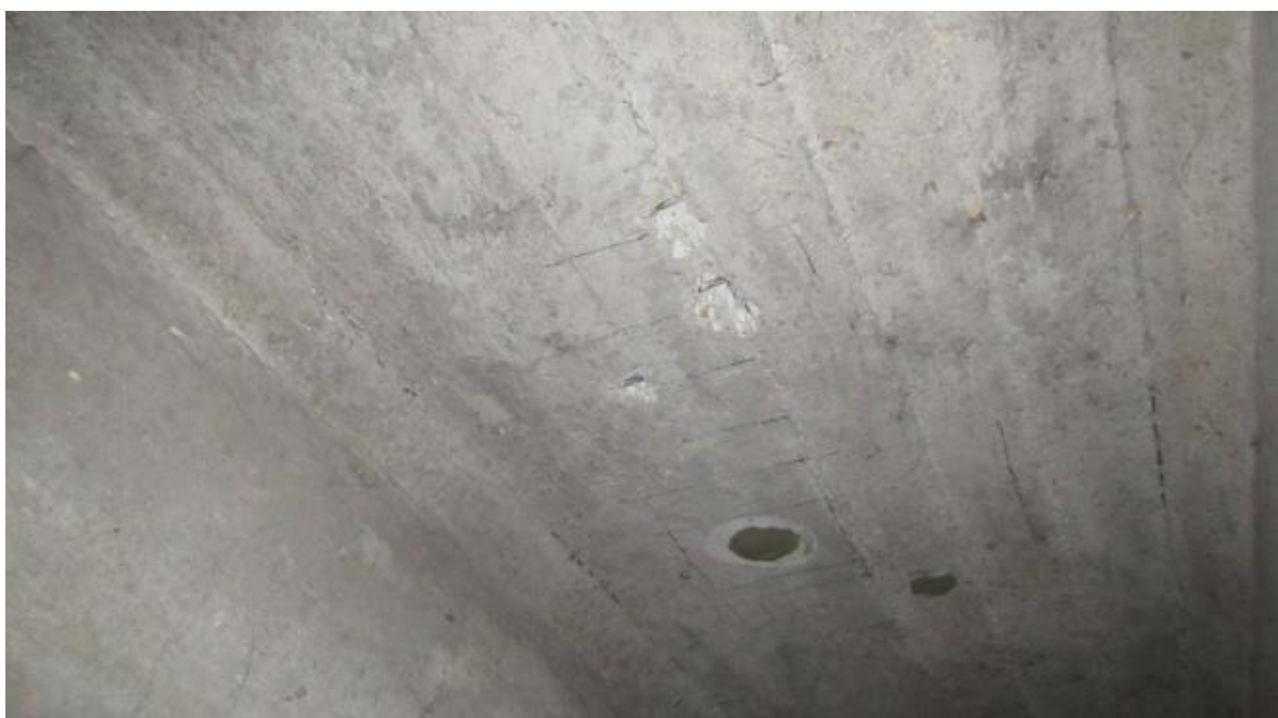
Obr. 56 Pohľad na skúšobné miesto s vykresleným rastrom polohy výztuže
