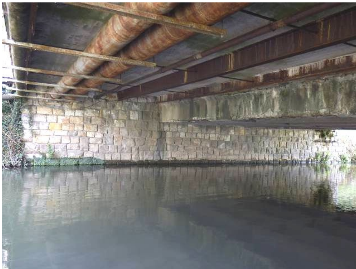
Obr. 26 Šikmý pohľad na oporu OP1 [20]
