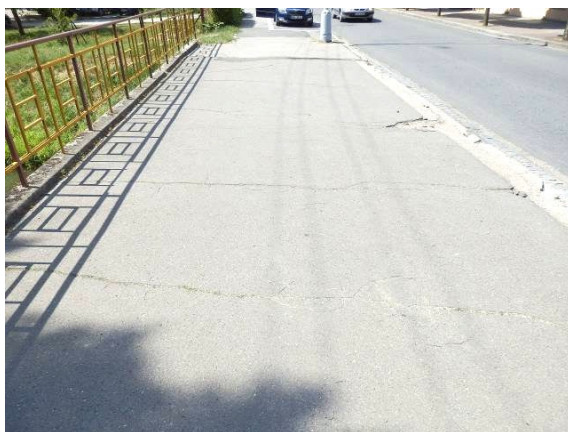
Obr. 49 Priečne trhliny (na ľavo) a trhliny pozdĺž obruby na chodníku (na pravo) [20]
