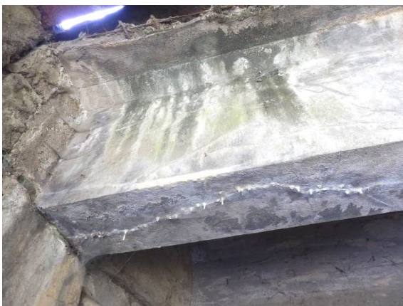
Obr. 43 Pohľad na otvor skrz a rozpad rímky zo spodnej strany [20]
