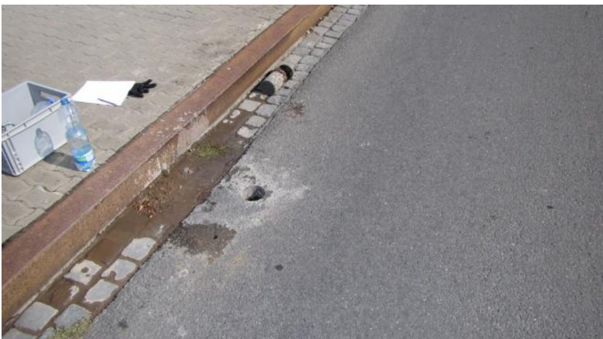
Obr.61 Pohľad na miesto vykonanej sondy SV-1
