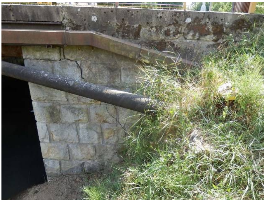
Obr. 29 Prasklina v krídle K2P [20]
