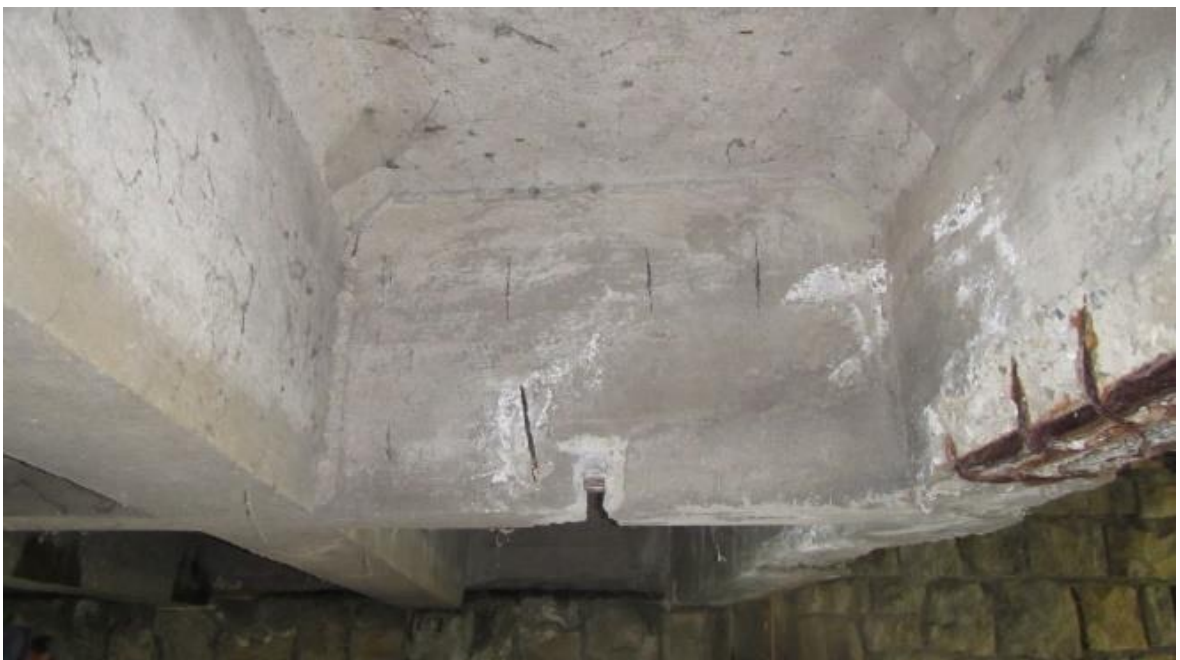
Obr. 69 Pohľad na miesto vykonanej sondy P-1
