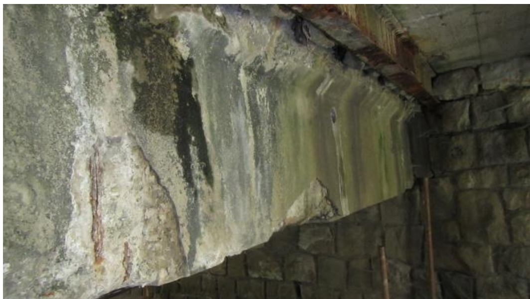
Obr. 59 Pohľad na krajný trám z ľavej (vtokovej) strany - sonda TS-1
