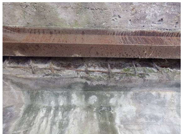
Obr. 43 Pohľad na otvor skrz a rozpad rímky zo spodnej strany [20]
