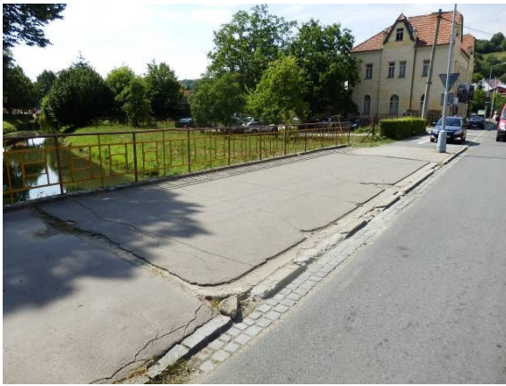
Obr. 41 Rozpad obruby na ľavej strane mostu [20]
