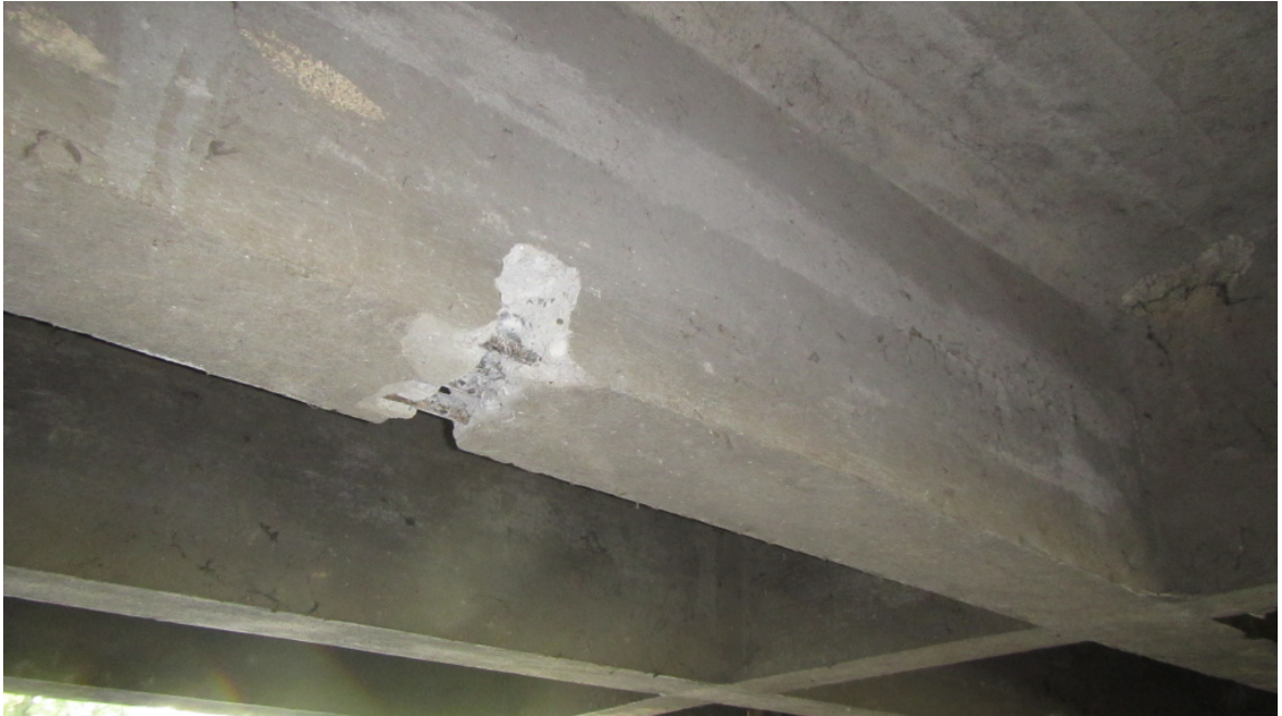
Obr. 68 Pohľad na miesto vykonanej sondy T-2
