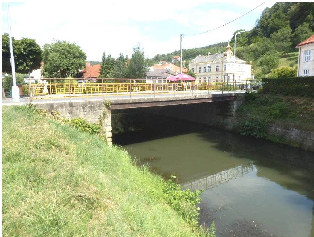
Obr. 22 Pohľad na ľavú (výtokovú) stranu mostu [20]
