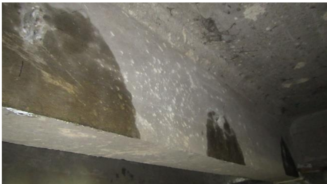
Obr. 60 Pohľad na stredný trám z ľavej (vtokovej) strany - sonda TS-2
