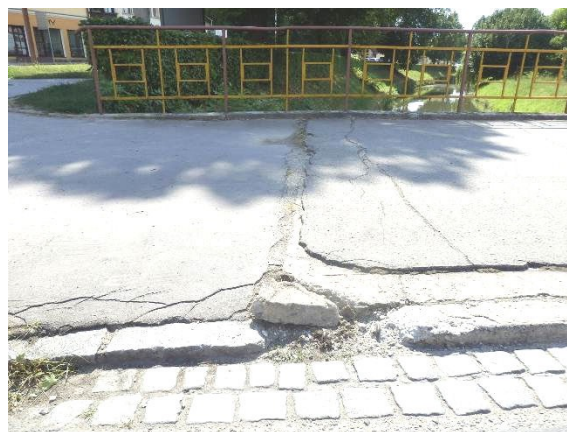
Obr. 49 Priečne trhliny (na ľavo) a trhliny pozdĺž obruby na chodníku (na pravo) [20]
