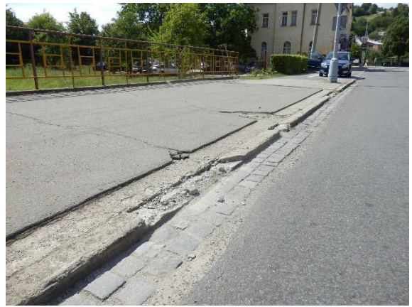
Obr. 41 Rozpad obruby na ľavej strane mostu [20]
