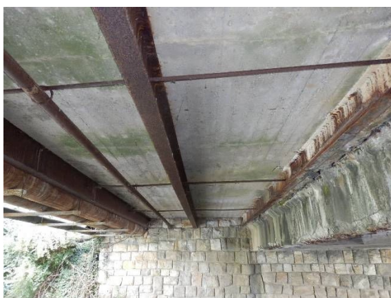
Obr. 38 Poškodenie ocelového trámu vplyvom zatekania na pravej strane [20]
