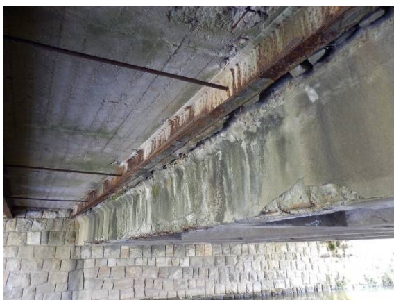
Obr. 45 Dôsledok rozpadnutej rímasy - kocky sa prepadajú [20]
