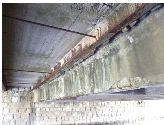
Obr. 38 Poškodenie ocelového trámu vplyvom zatekania na pravej strane [20]
