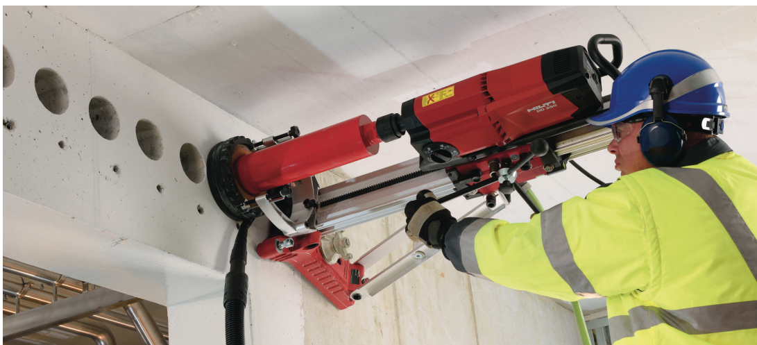
Obr. 11 Realizácia jadrových vývrtov vodorovne prístrojom SPX-H (BL) Hilti [13]
