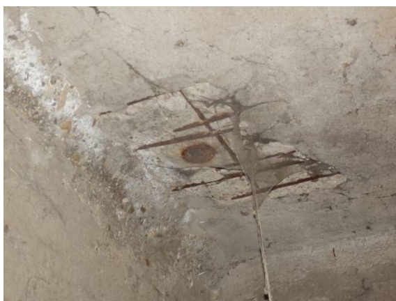
Obr. 35 Priesaky okolo starého odvodňovača a pohľad na vnútorné trámy a pole [20]
