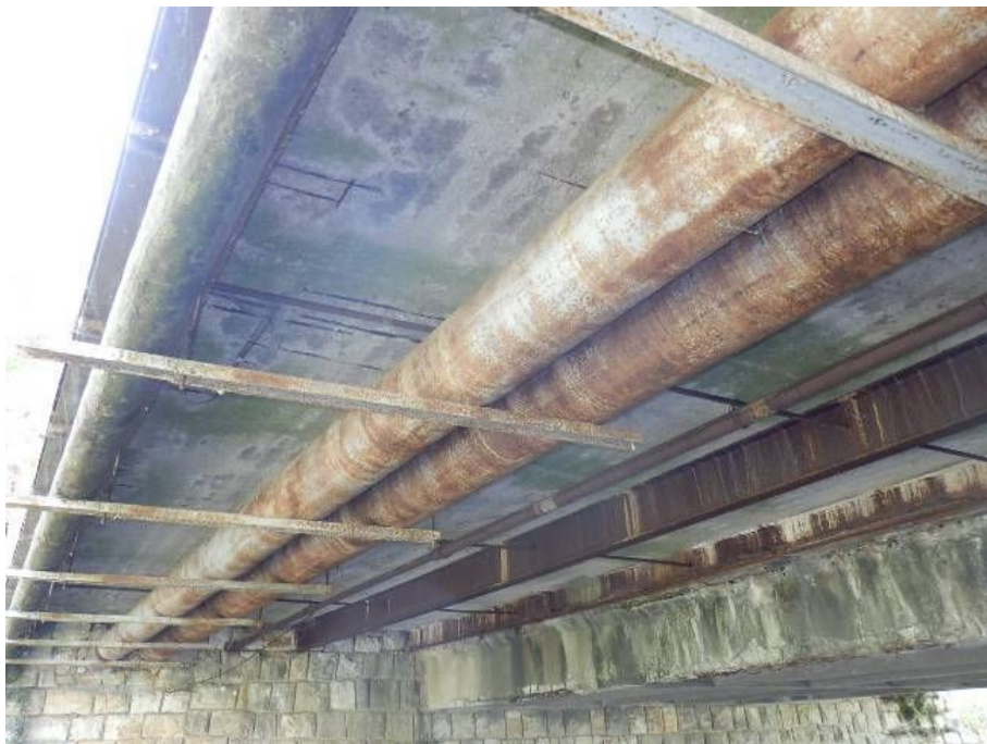
Obr. 53 Pohľad na ocelové chráničky DN 300 a DN 90 [20]
