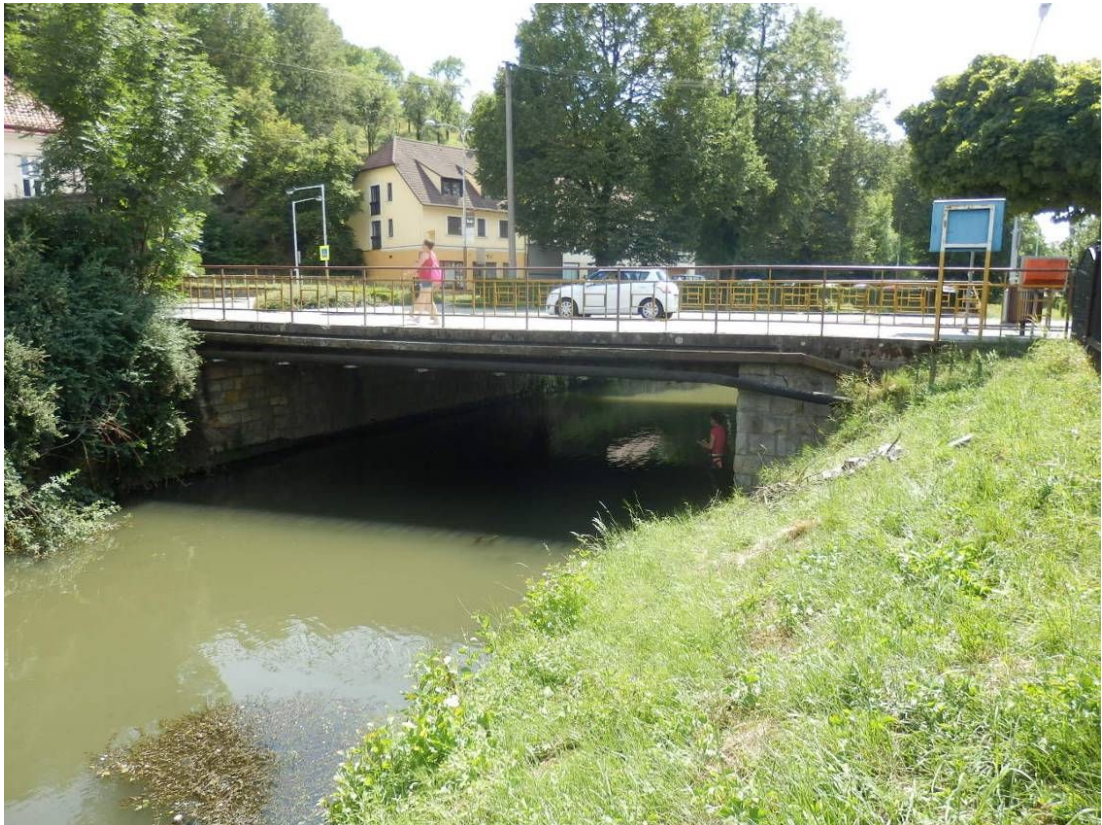
Obr. 23 Pohľad na pravú (vtokovú) stranu mostu [20]
