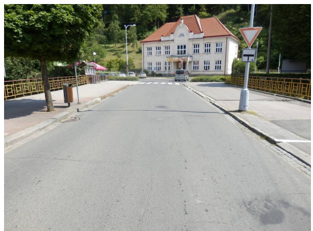
Obr. 25 Celkový pohľad na most (od OP2 k OP1) - vtok je vľavo [20]
