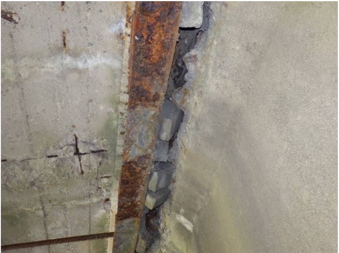
Obr. 46 Detail na prepádajúce sa kostky [20]
