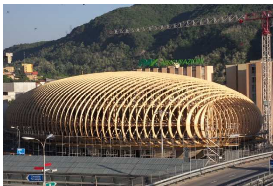
Obr. 2-9 Pohled na podpůrnou konstrukci bednění [16]
