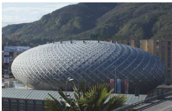
Obr. 2-10 Pohled na dokončenou konstrukci [15]
