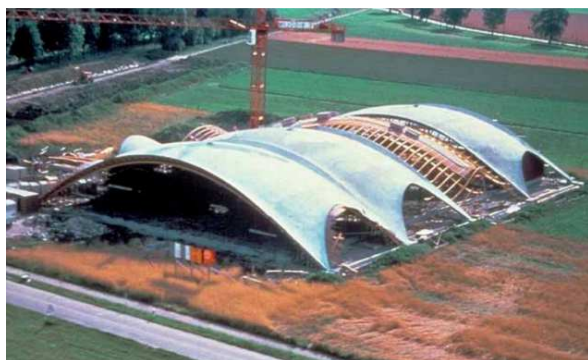
Obr. 2-19 Tenisová hala v Düdingenu – postupná výstavba [21]
