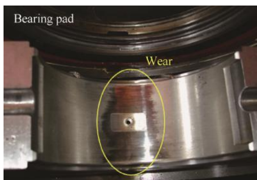
Obr. 1.1 Opotřebení ložiska, ke kterému došlo při tlučení oleje (převzato z [5]).
