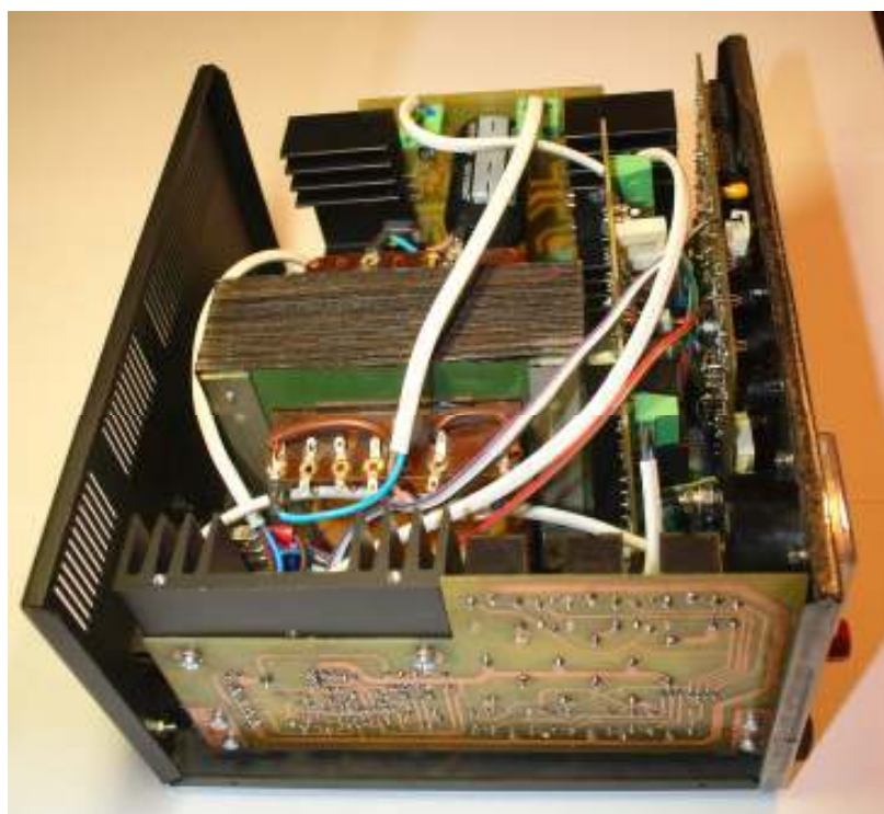
Obr. 9.2 Fotografie - pohled z levého boku
