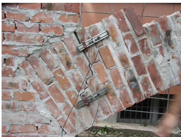
Obr. 7.71 Hollanové můstky u paty klenby, H\_N\_Horní/Dolní
