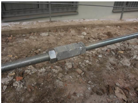
Obr. 7.3 Ocelové táhlo s maticemi
