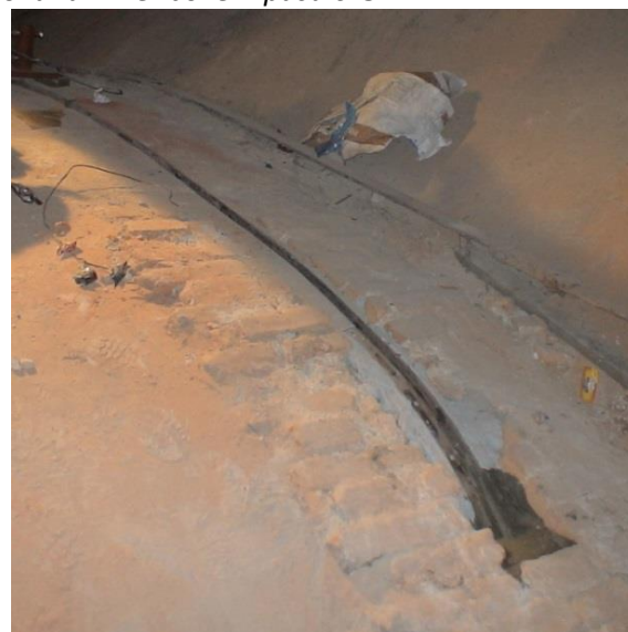
Obr. 8.14 Vedení lana po rubu klenby a deviator
