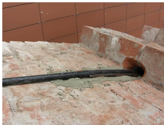
Obr. 7.12 Deviátor – blíž k posuvné patě klenby
