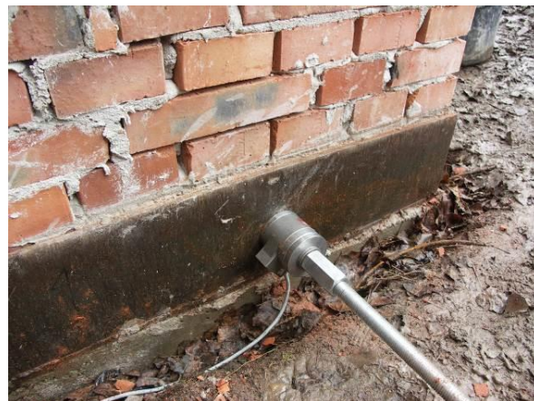
Obr. 7.6 Osazený siloměr na ocelovém táhle u neposuvné paty klenby
