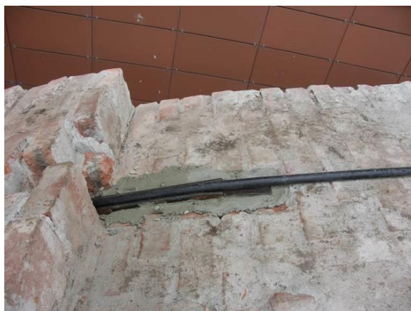
Obr. 7.11 Deviátor – blíž k neposuvné patě klenby
