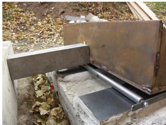
Obr. 7.8 Valivé ložisko s posuvnou patkou
