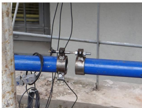
Obr. 7.14 Osazení indukčnostního snímače na ramenátovém zesilovači
