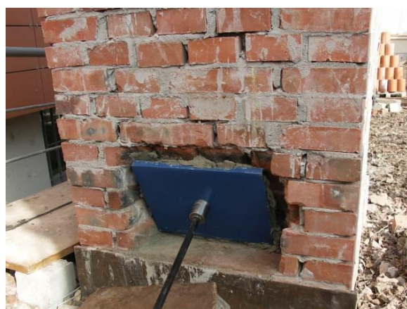
Obr. 7.9 Kotevní sklípek – neposuvná patka klenby
