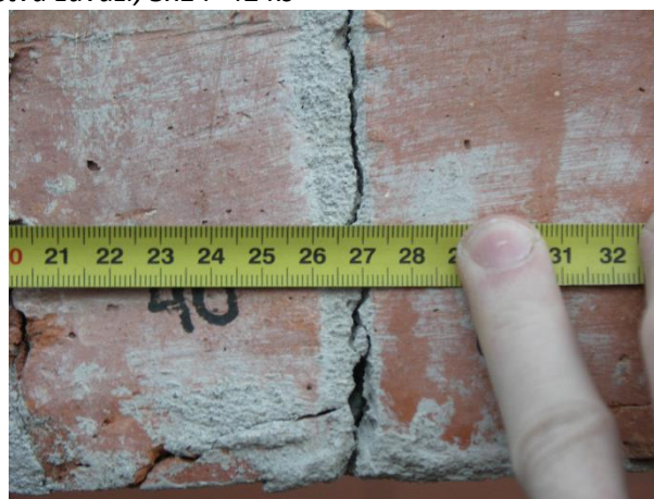
Obr. 7.44 Trhлина ve vrcholu, 2 mm
