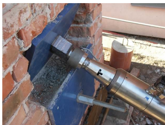
Obr. 7.10 Kotevní sklípek – posuvná patka klenby s napínacím lisem
