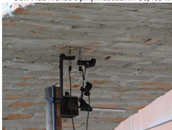
Obr. 7.34 Měření svislé deformace ve vrcholu klenby U_z
