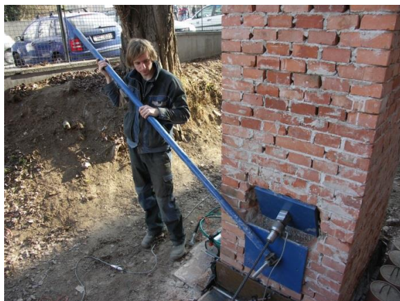
Obr. 7.63 Povolování matice ocelového táhla
