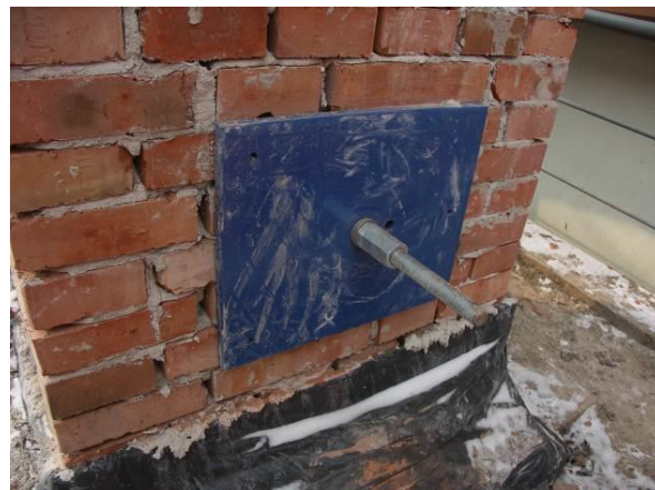
Obr. 7.4 Ocelová roznášecí deska
