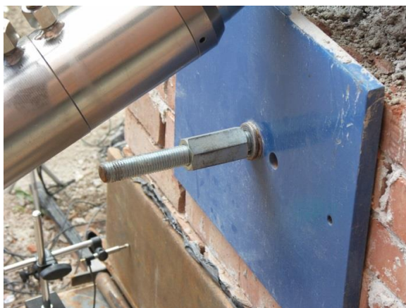
Obr. 7.83 Povolená matice ocelového táhla
