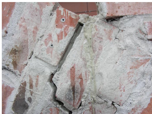
Obr. 7.47 Zainjektovaná trhlina cementovou maltou
