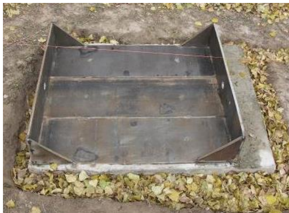
Obr. 7.7 Ocelová patka – neposuvná patka klenby
