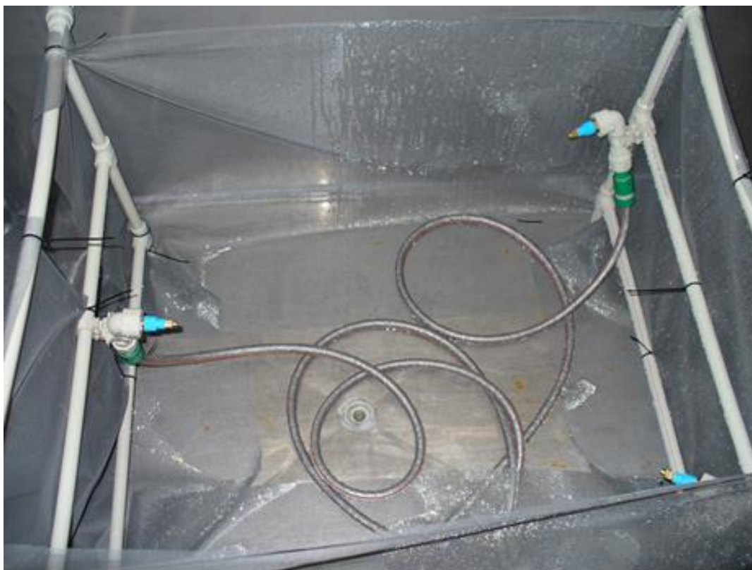
Obr. 43 – Instalace trysek do VZT
