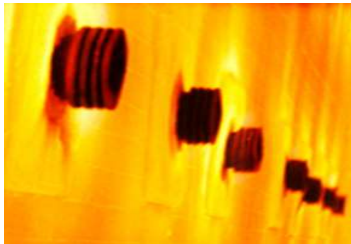
Obr. 132 Hořáky ve stěně pyrolyzní pece. [64]
