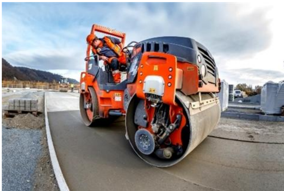
Obr. 4.2 Válcování betonové směsi jako druh hutnění [08]
