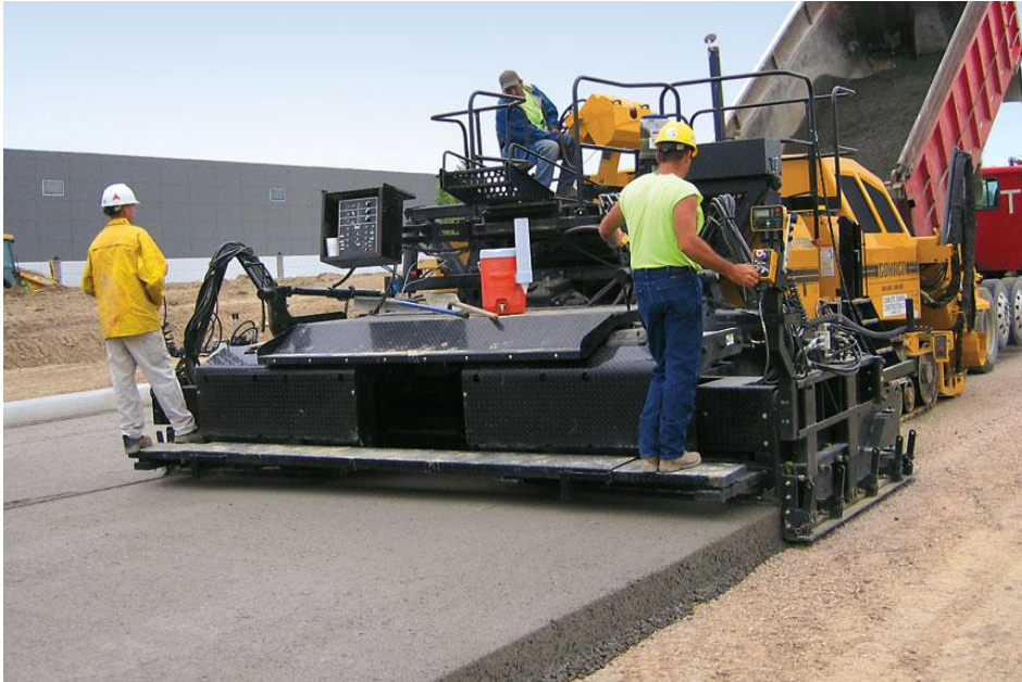
Obr. 2.2 Pokládka betonové směsi finišerem [O6]
