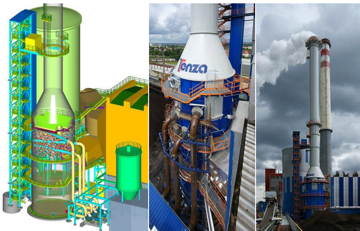
Obr. 15, Technologie odsiřování zprovozněných kotlů teplárny Plzeňská Energetika, a.s. [25]
