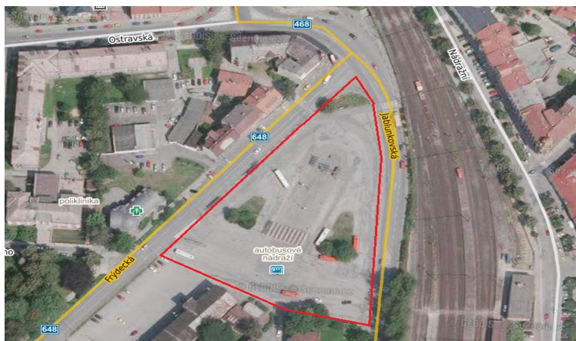
Obr. č. 2 – Letecký pohled na stávající autobusové nádraží – řešené území
