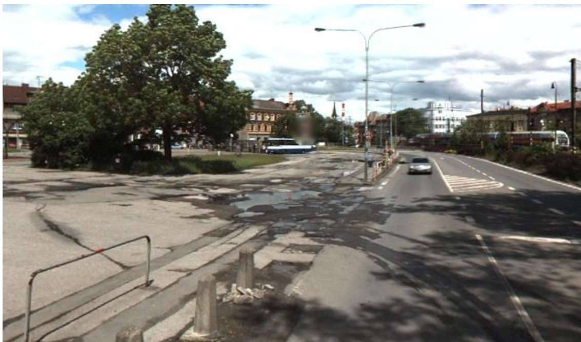
Obr. č. 3 – Pohled na stávající vjezd a výjezd – ulice Jablunkovská
