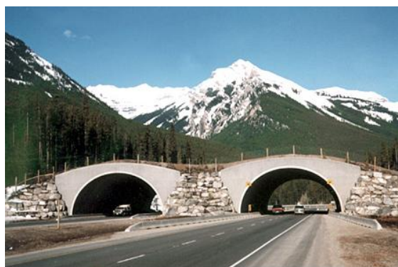
Obr. 1.2 Přechod pro zvěř přes Trans-Canada Highway; vpravo výstavba (Montgomery, 1994).
