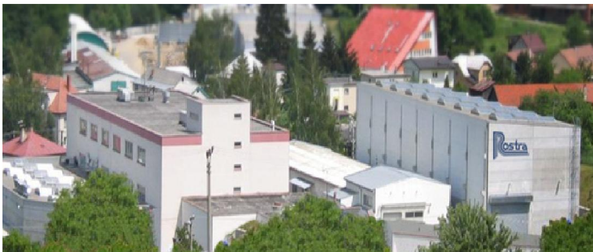
Obr. 3 Pohled na sídlo společnosti Rostra s.r.o. [9]
