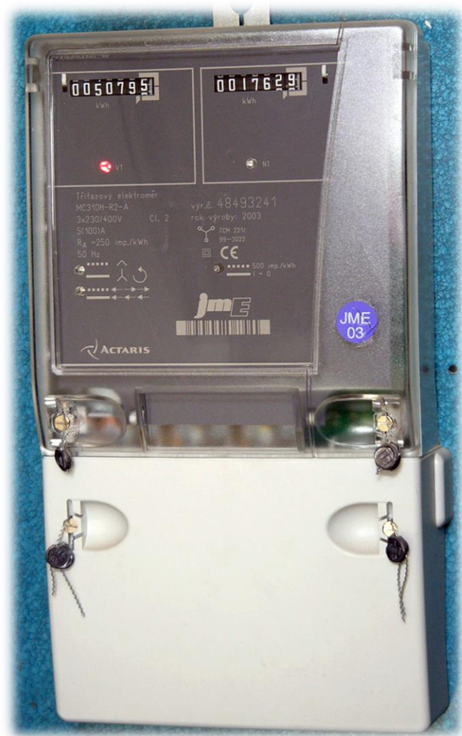
Obr. 1.2: Zástupce dvousazbového třífázového elektroměru pro domácnosti [2]
