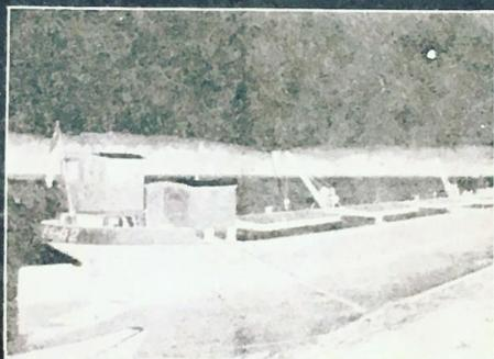
Obr. 1. Betonová vlečná loď o 700 t nosnosti postavená „Syndikátem pro stavbu betonových lodí a vagonů“ a spuštěná dne 3. července 1921 v Kremži na Dunaji.
