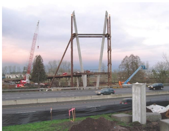
Obr. 3.35 Výroba a osazení pylonu
