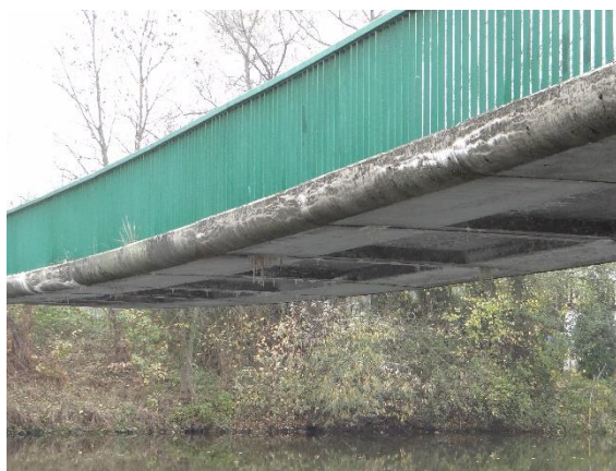
Obr. 4.28 Krápníky a výluhy v polovině rozpětí
