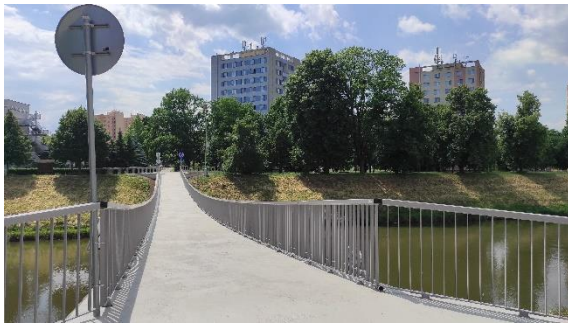
Obr. 5.19 Osazení zábradlí
