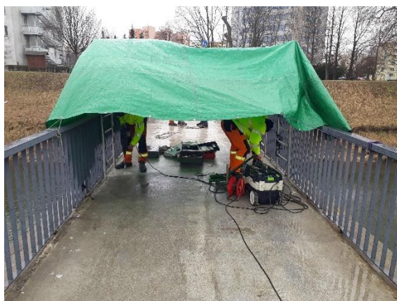
Obr. 4.13 První etapa průzkumu – lávka přes Moravu v Kroměříži
