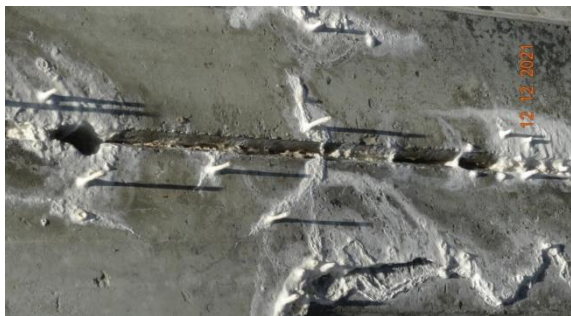
Obr. 6.6 Detail stavu spáry mezi segmenty 9 a 10 v roce 2021 při hlavní prohlídce [26] – návodní strana
