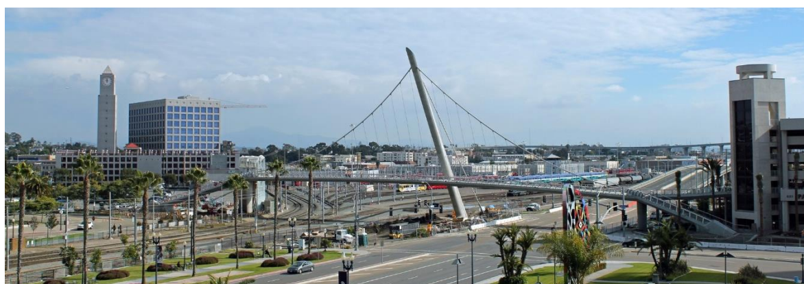
Obr. 1.9 Lávka přes Harbor Drive (dostupné na www.shp.eu a [64])
