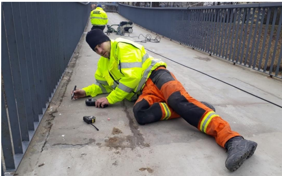
Obr. 4.2 Vyhledání betonářské výztuže pomocí indikátoru výztuže na lávce přes řeku Moravu v Kroměříži
