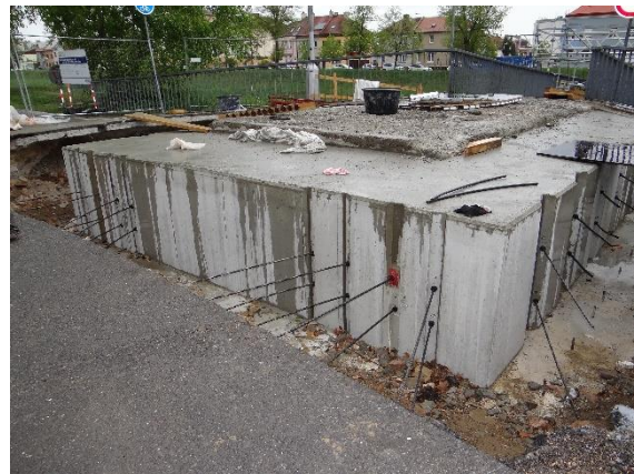
Obr. 5.14 Stav po betonáži kotevního bloku za opěrou OP2
