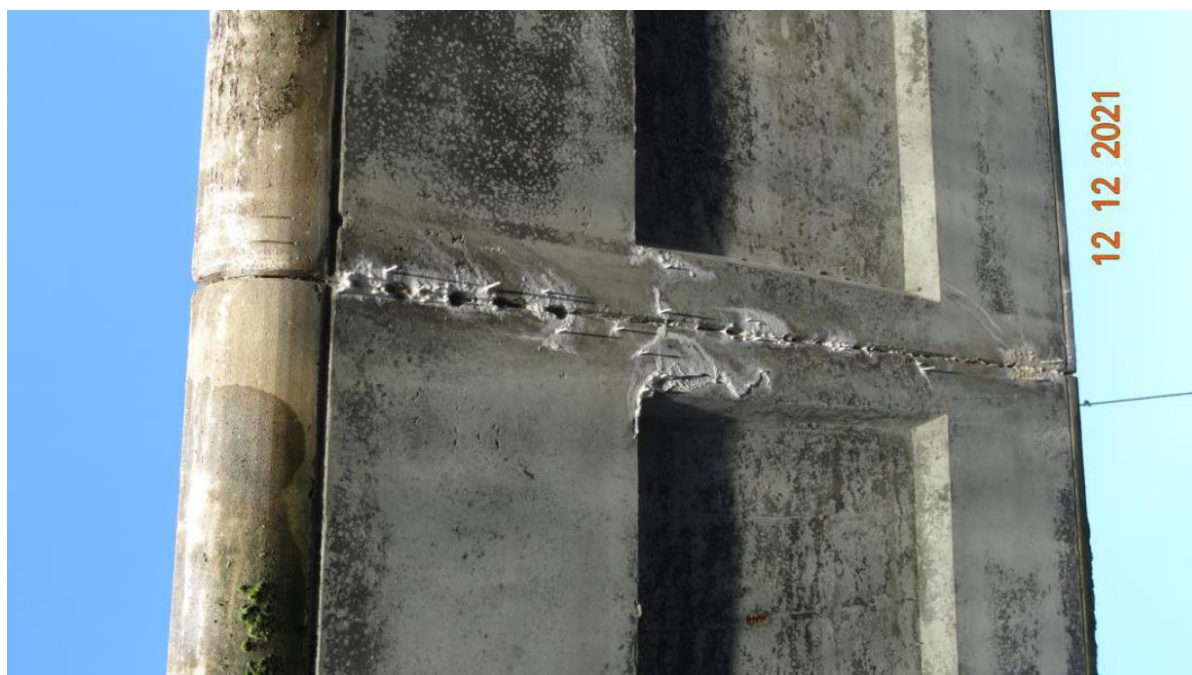
Obr. 6.5 Stav spáry mezi segmenty 9 a 10 v roce 2021 při hlavní prohlídce [26]
