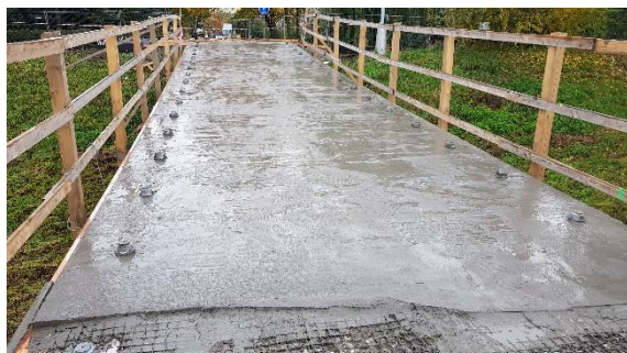
Obr. 5.17 Betonáž mikrobetonu SIKA vyztuženého sítí z nekorodující výztuže
