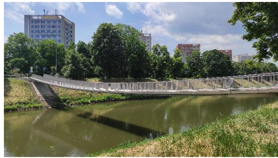
Obr. 5.20 Lávka po dokončení
