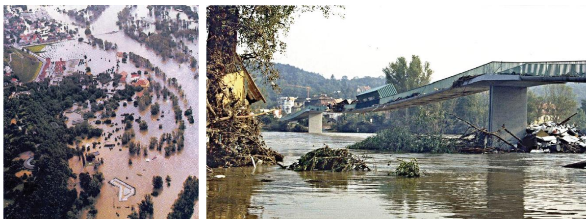
Obr. 4.22 Lávka v Praze Tróji při povodni v roce 2002 (vlevo nahoře) a po opadnutí vody (vpravo) [60]
