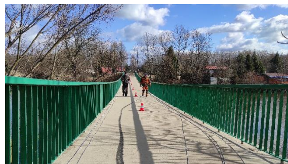
Obr. 4.4 Vybuzení lávky přechodem dvou osob
