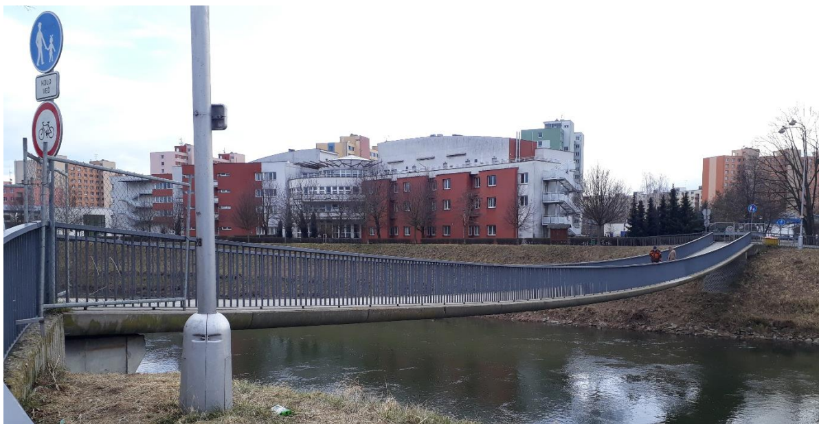
Obr. 4.15 Lávka přes řeku Moravu v Kroměříži (březen 2018)
