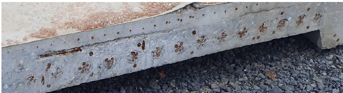
Obr. 5.25 Detail sanační vrstvy betonu na horní povrchu nosné konstrukce 72 segmentu od Císařského ostrova
