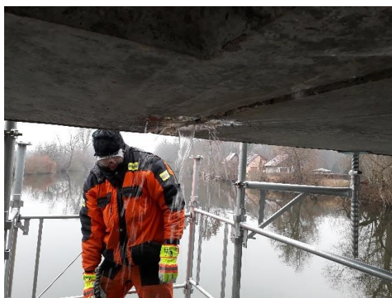
Obr. 4.19 Vodní nálev ze sondy k nosné výztuži ve spáře na návodní straně mezi segmenty č. 9 a 10 (číslováno od OP1)
