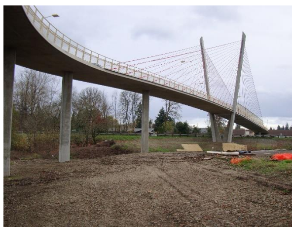
Obr. 3.37 Dokončení montáže segmentů a betonáž spřažené desky
