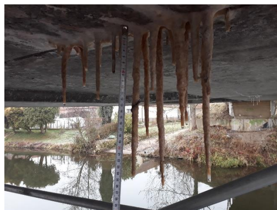
Obr. 4.29 Detail výluh a aktivních krápníků (na jeho konci je kapka vody)
