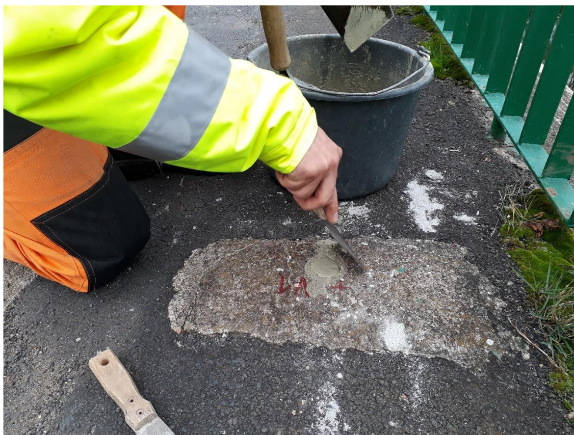
Obr. 4.10 Zapravení sondy nesmrštivou zálivkou
