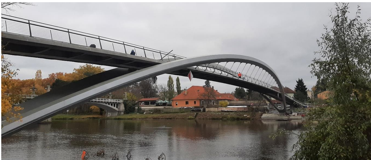
Obr. 1.3 Lávka přes Labe v Nymburce při dynamické zkoušce (2021)
