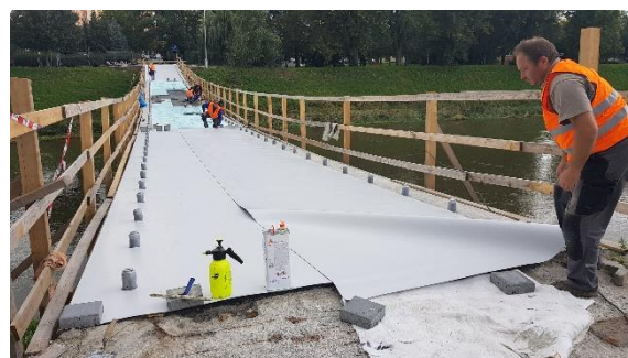
Obr. 5.16 Pokládka hydroizolace a polystyrenu
