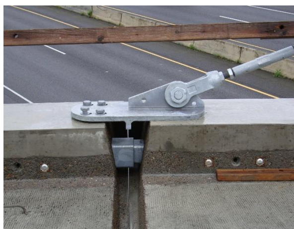
Obr. 3.36 Montáž segmentů a jejich spojení
