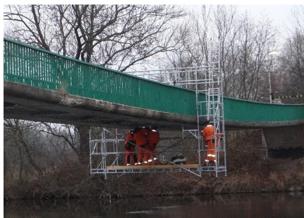
Obr. 4.14 Druhá etapa průzkumu – lávka přes Ohří v Radonicích nad Ohří
