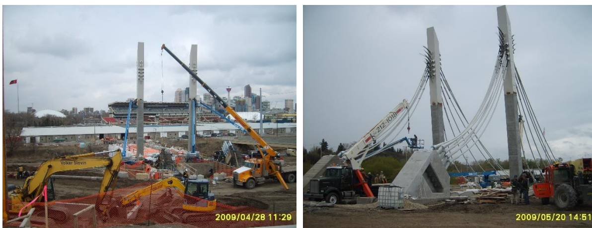
Obr. 3.30 Montáž horní ocelové části pylonu a osazení závěsů
