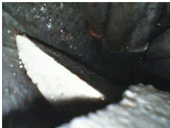
Obr. 4.12 Nezainjektovaný kanálek předpínací výztuže (viditelná hladina injektáže)
