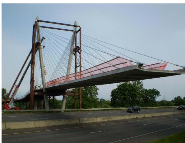
Obr. 3.36 Montáž segmentů a jejich spojení
