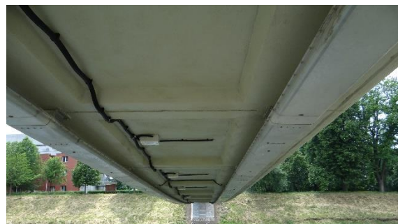
Obr. 5.18 Sanace spodního povrchu a instalace monitorovacího systému
