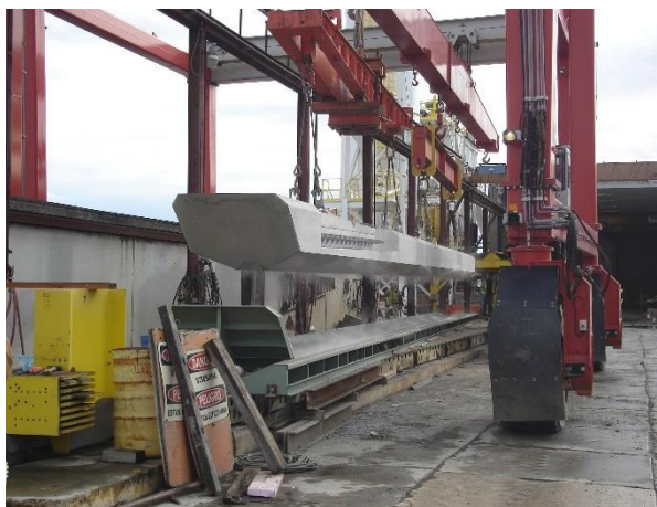
Obr. 3.35 Výroba a osazení pylonu
