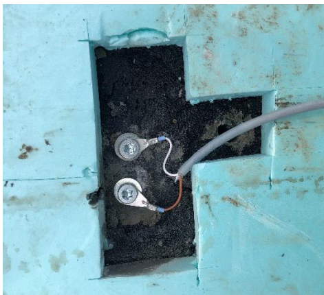
Obr. 5.21 Instalace čidel vlhkosti betonu (odporová metoda)
