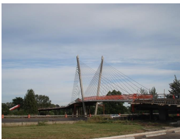
Obr. 3.37 Dokončení montáže segmentů a betonáž spřažené desky
