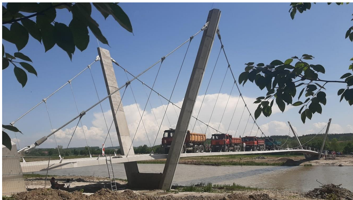
Obr. 1.8 Lávka přes řeku Bečvu u obce Ústí při statické zatěžovací zkoušce (2022)
